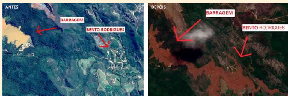
Imagem 1: Rompimento barragem de rejeitos em Mariana (MG).
