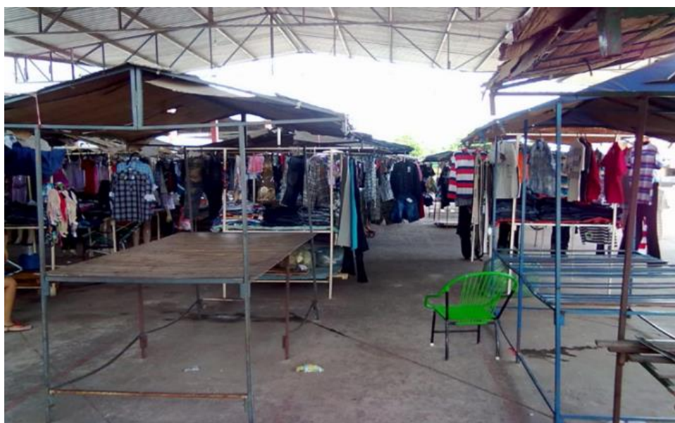
Figura 1 – Mercado Municipal de Porto Nacional – TO, sem a reforma.
