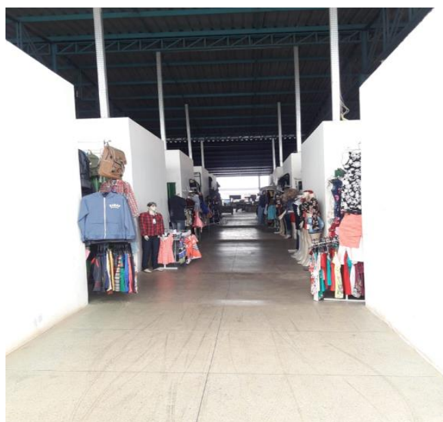
Figura 3 – Estrutura interna do local reformado.
