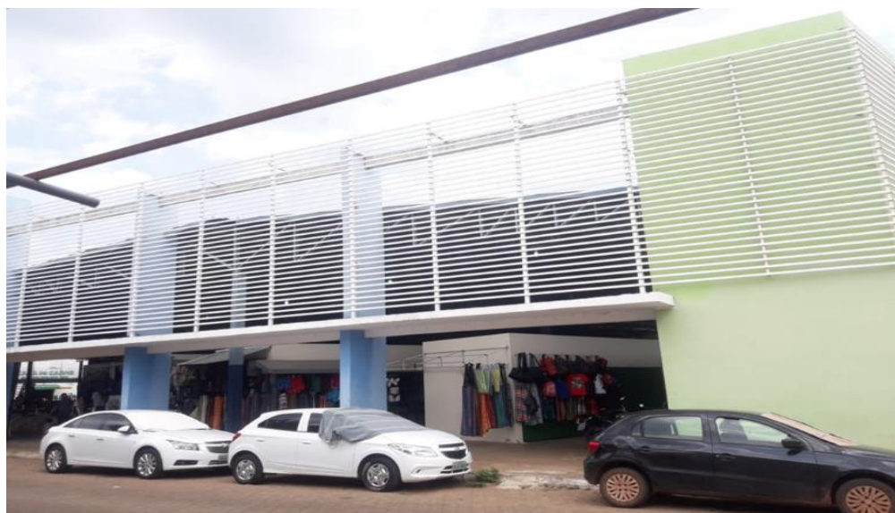
Figura 2 – Estrutura física externa do local reformado.
