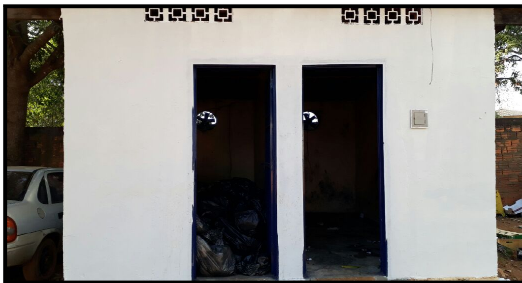
Imagem 1 Local de Armazenamento do Lixo Hospitalar
