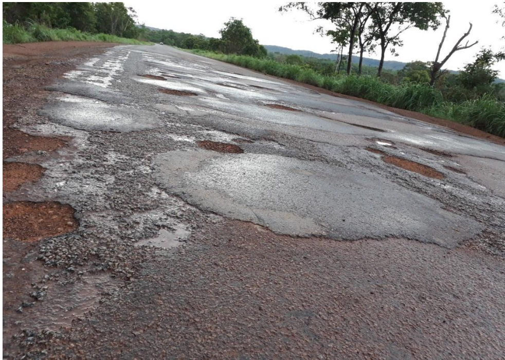
Figura 3: Trecho da Rodovia TO 070 com sua extensão rodoviária cheia de buracos e com algumas operações desgastadas de tapa buracos.
