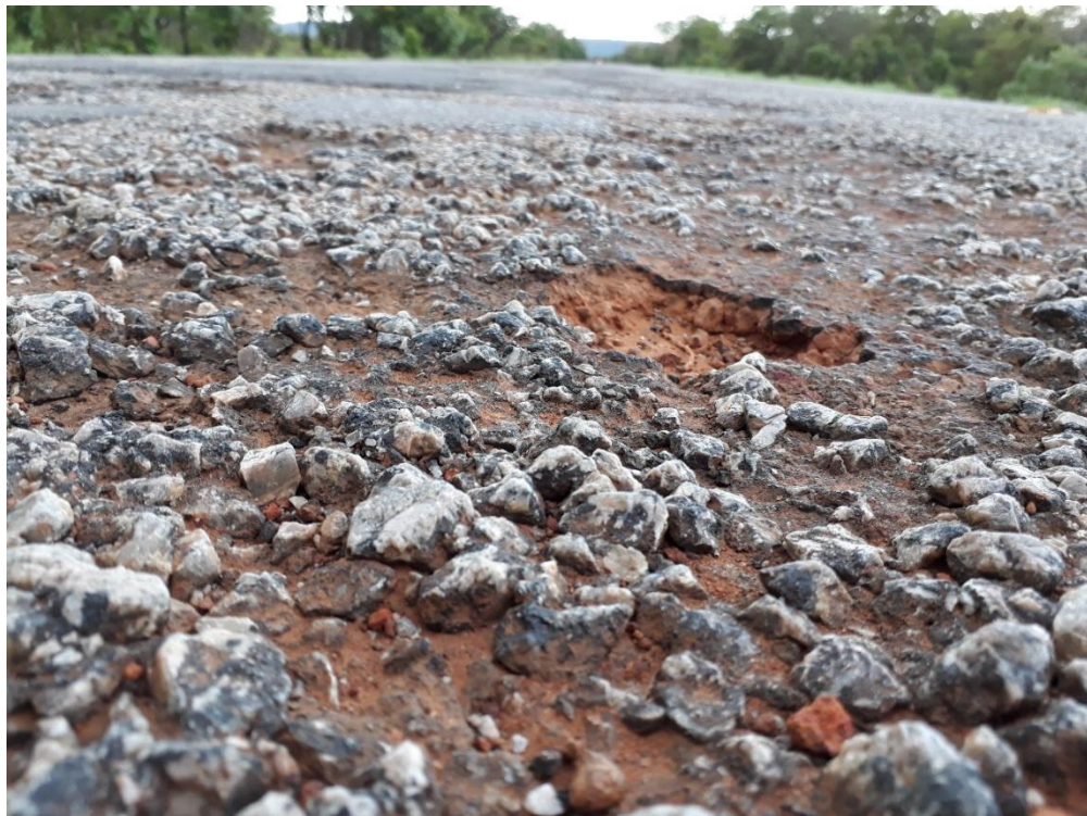
Figura 5: Pavimentação da Rodovia TO 070
