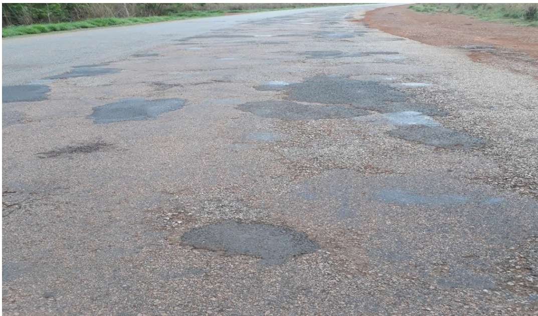
Figura 4: Operação Tapa Buracos realizada em parte da Rodovia TO 070.
