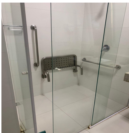
Figura 08 - Barras de apoio no box do banheiro
