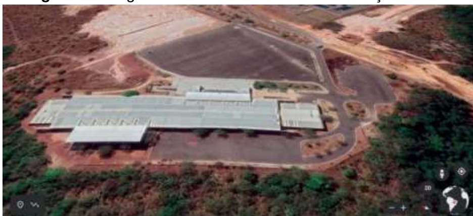
Figura 3: Imagem Satélite do Centro de Convenções
