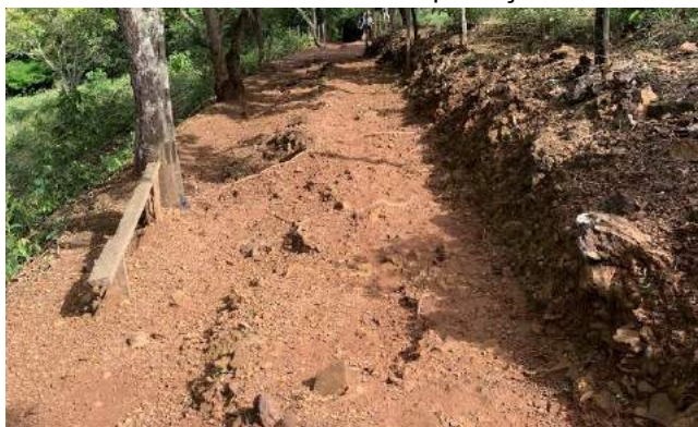
Figura 25 – Trecho da Trilha com Compactação e Erosão no Solo
