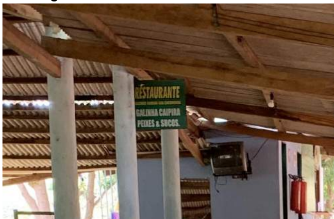
Figura 13 – Placa Sinalizando o Restaurante
