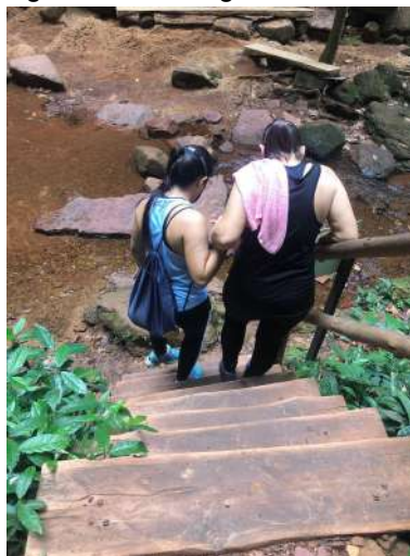
Figura 23: Escada íngreme, com degraus curtos e corrimão unilateral.
