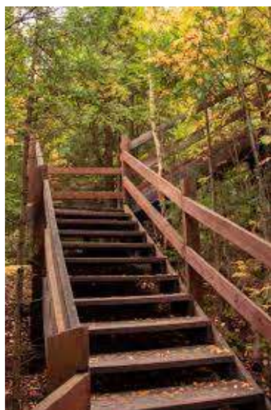
Figura 24: Modelo de escada com degraus largos e corrimãos em ambos os lados.
