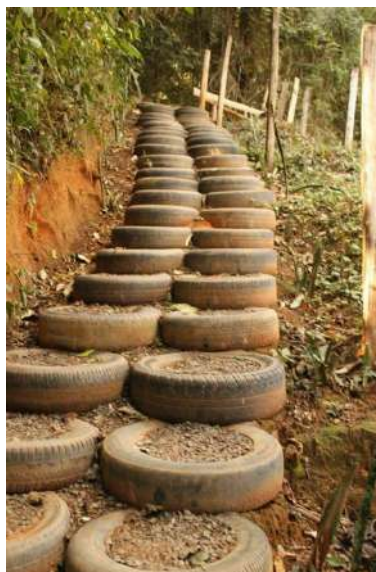
Figura 19: Exemplo de utilização de pneus como escadas.
