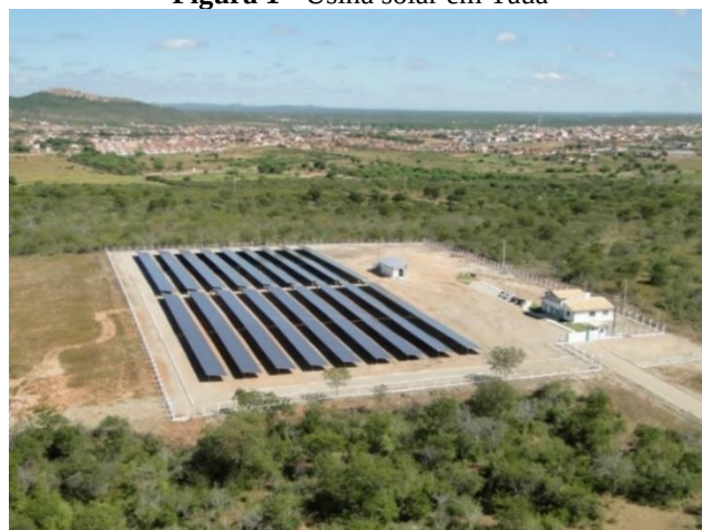
Figura 1 - Usina solar em Tauá
