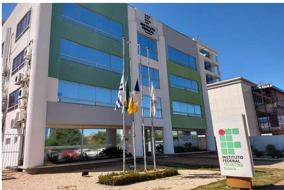
Figura 14 - Fachada da Reitoria do Instituto Federal do Tocantins
