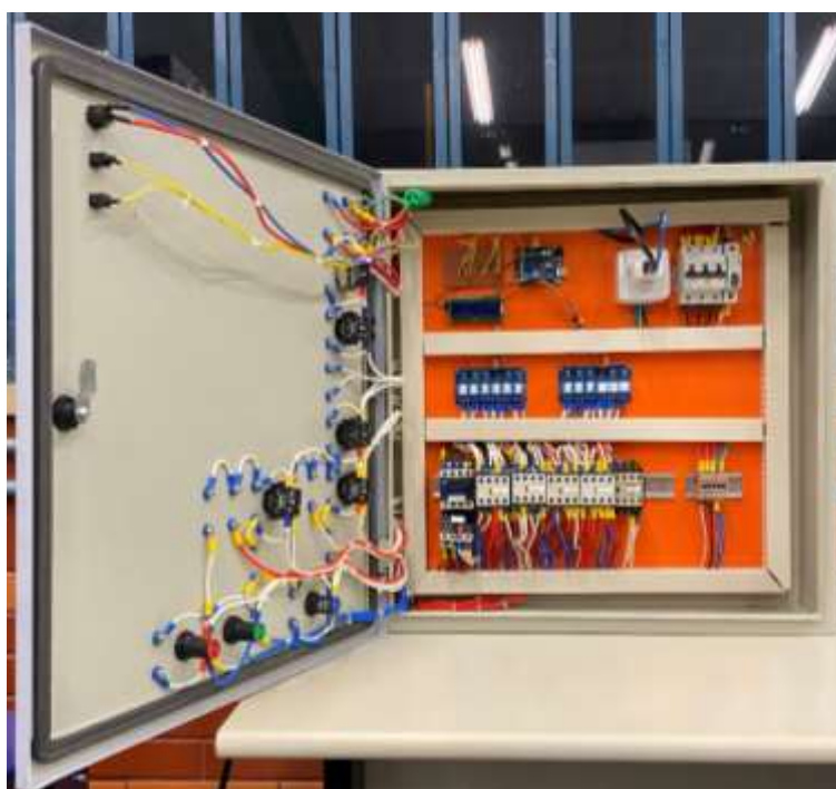
Figura 71 – Interior do painel finalizado
