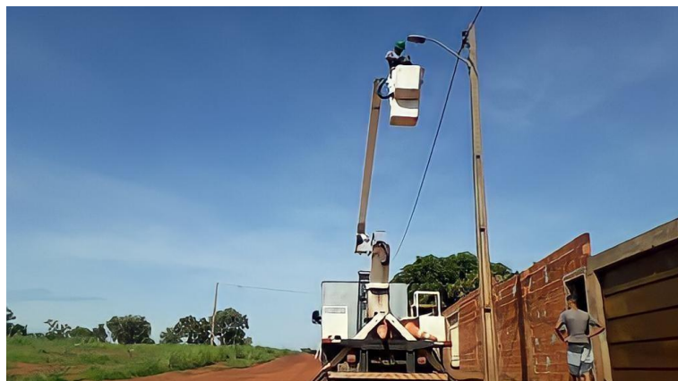
Figura 4 - Serviço de manutenção da iluminação pública.
