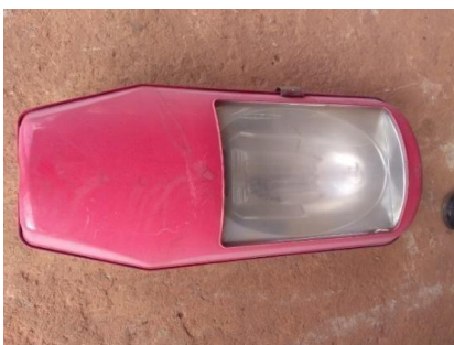
Figura 21 - Modelo de Luminária Instalada na NS-02 anterior a troca pela tecnologia LED.
