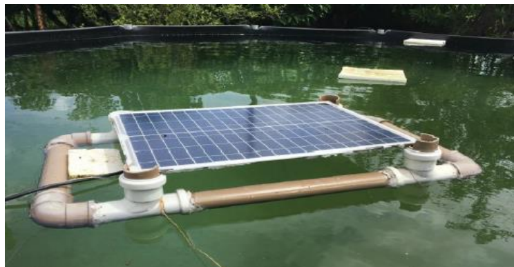
Figura 12 - Módulo FV instalado sobre a estrutura de PVC
