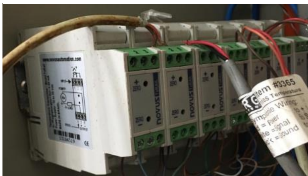
Figura 16- Transmissores de temperatura NOVUS
