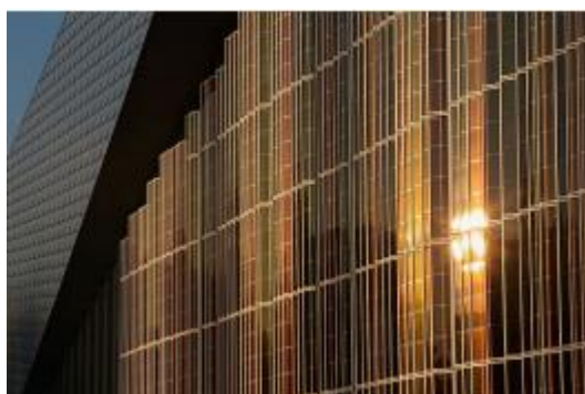
Figura 8 - Células sensibilizadas por corante na lateral de um edifício
