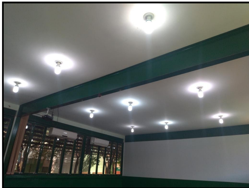
Figura 12: Sala 6 do Blocos III do IFTO Campus Porto Nacional.
