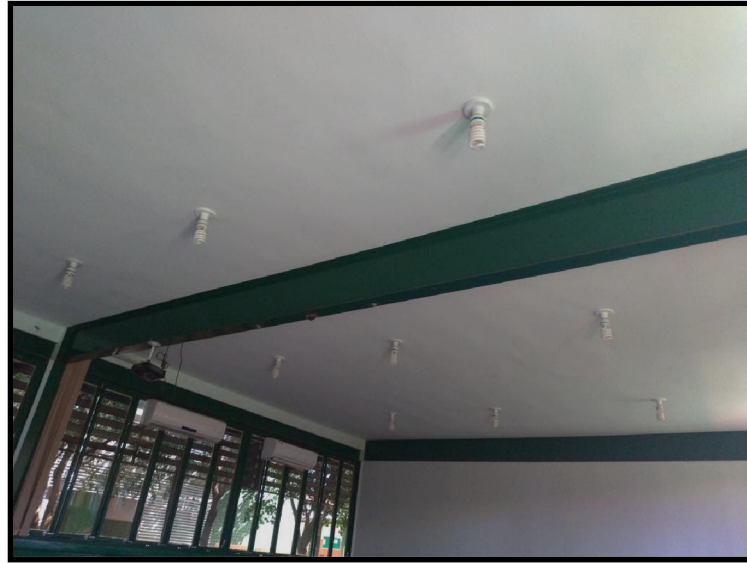
Figura 11 – Sala 6 do Blocos III do IFTO Campus Porto Nacional.
