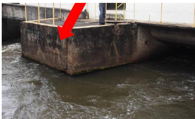
Figura 50: Local de instalação sonda de jusante.
