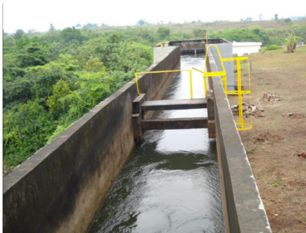
Figura 11: Canal de Adução da PCH Lajes.
