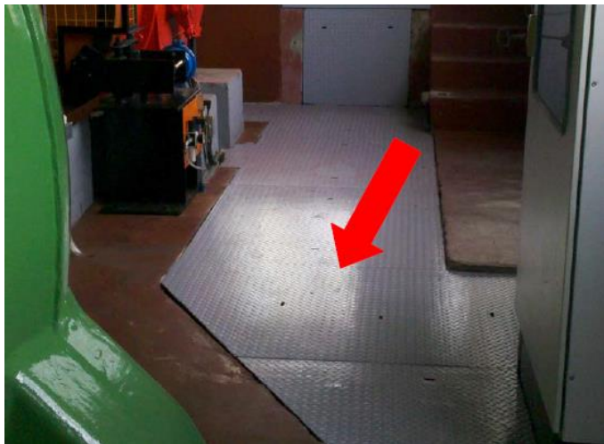
Figura 60: Local de passagem dos cabos de sinal.
