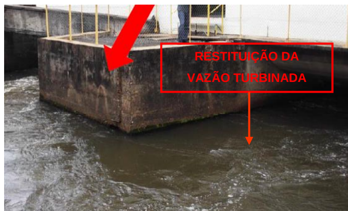
Figura 22: Canal de fuga da PCH Lajes.
