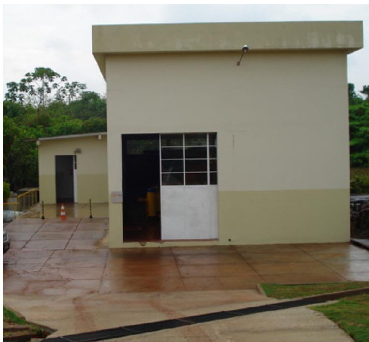
Figura 16: Visão externa da casa de máquinas da PCH Lajes.
