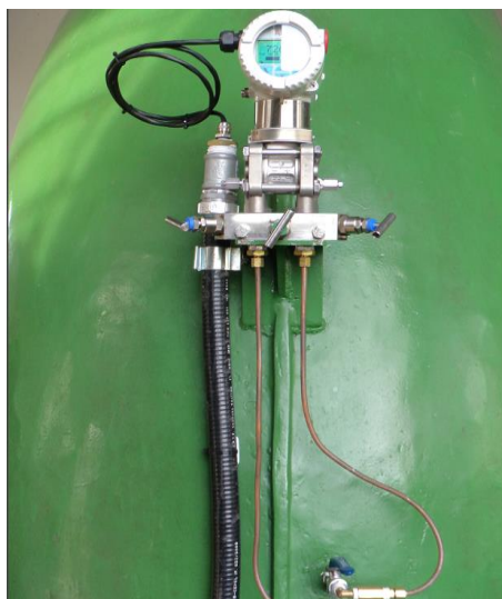
Figura 53: Transmissor de pressão diferencial.
