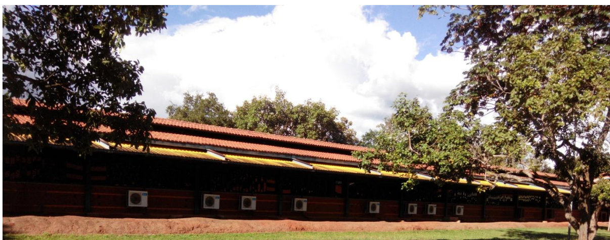
Figura 26: Proteção das unidades condensadoras de ar do Bloco 9 Fonte: Arquivo pessoal, 2015
