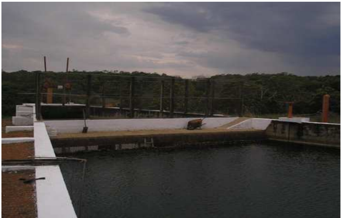
Figura 3.9: Câmara de carga
