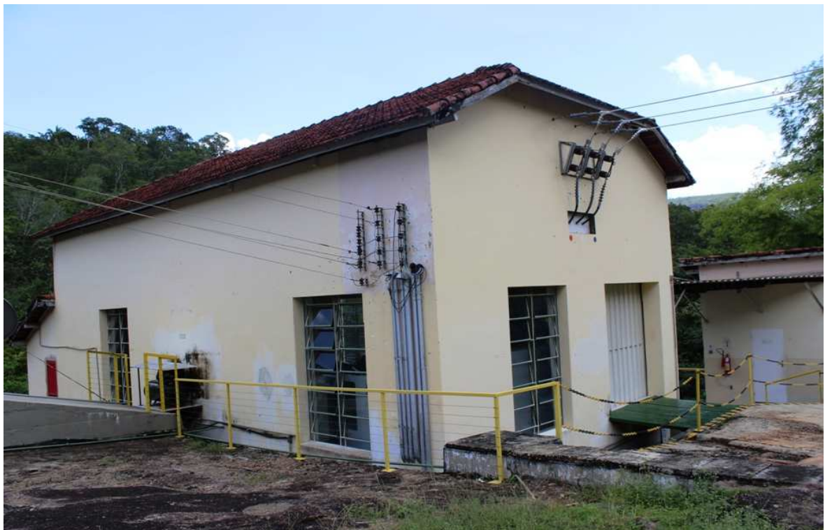
Figura 3.12: Casa de máquinas PCH Lajeado.
