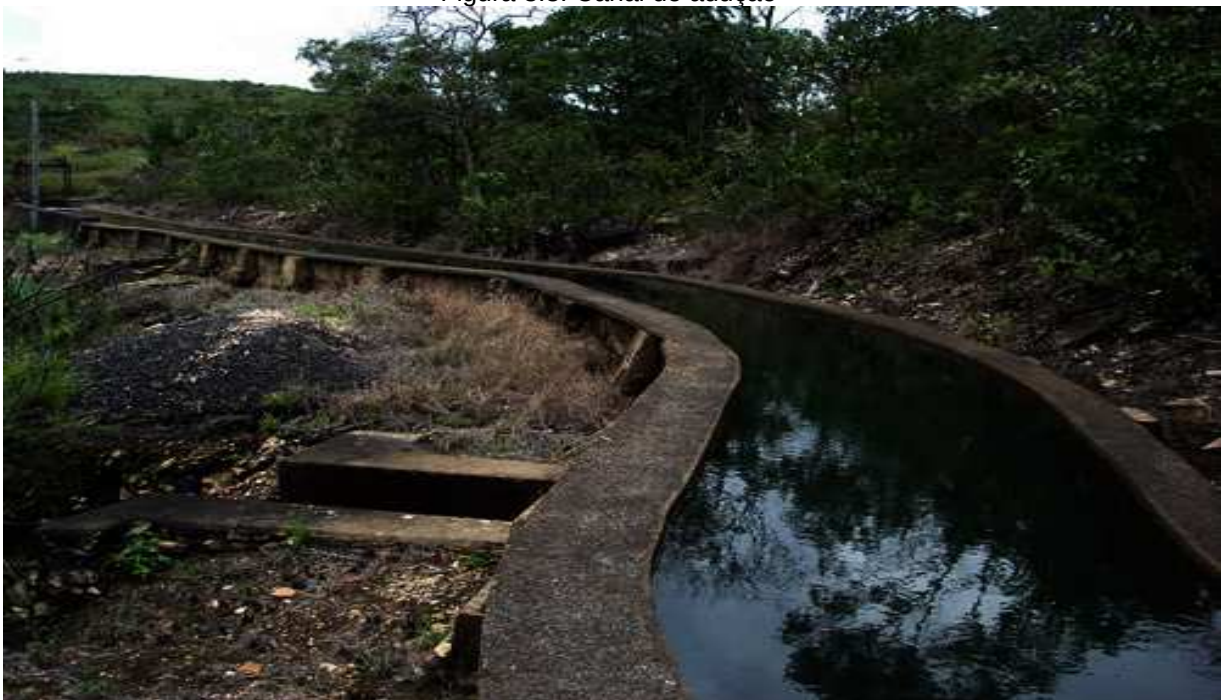
Figura 3.8: Canal de adução
