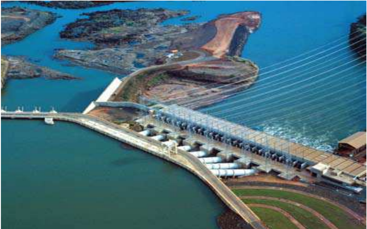
Figura 2.1: Usina Hidrelétrica de Marimbondo.
