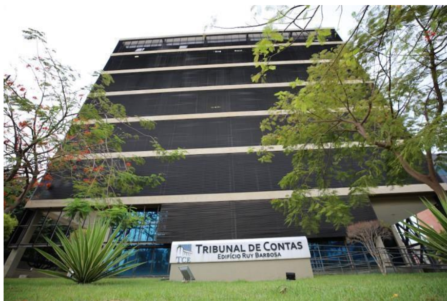
Figura 14 - Edifício do Tribunal de Contas do Estado do Tocantins, localizado em Palmas
