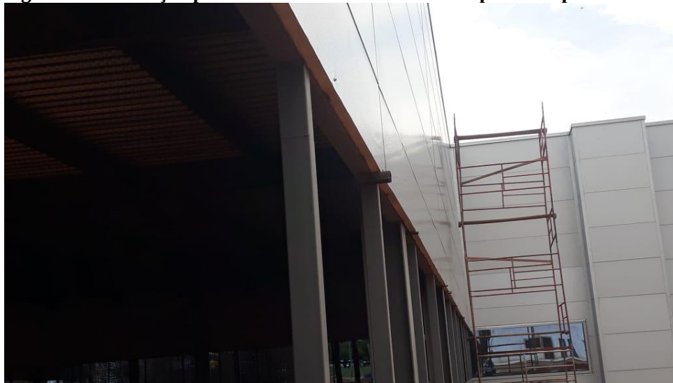
Figura 3 – Instalação placa sanduíche Bloco Radioterapia – Hospital de Amor
