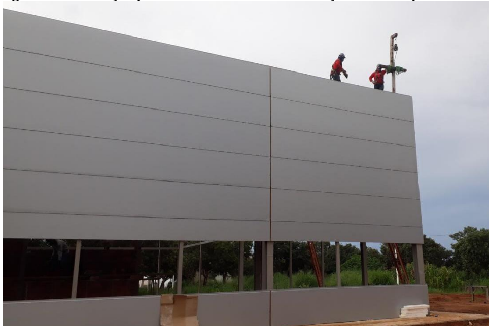
Figura 4 – Instalação placa sanduíche Bloco Circulação III – Hospital de Amor
