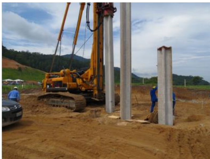
Figura 6 - Execução de estaca pré-moldada
