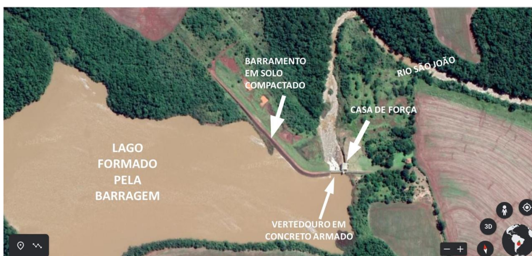
Figura 26 – Vista aérea da Barragem
