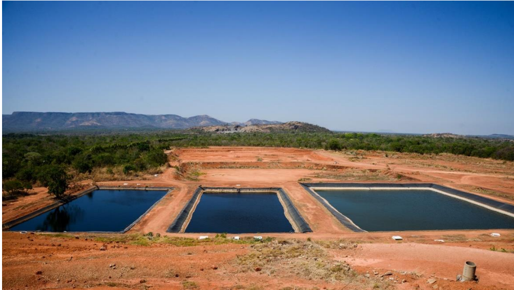
Figura 5 - Tanques de tratamento do Aterro Sanitário de Palmas - TO.
