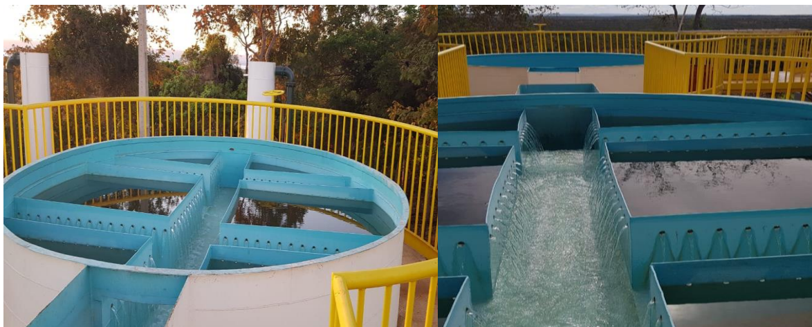
Figura 6: Filtros FAP e FAD - ETA Dupla Filtração
