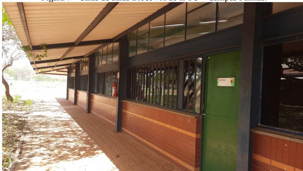
Figura 7 – Salas de aulas Bloco 7A do IFTO – Campus Palmas.
