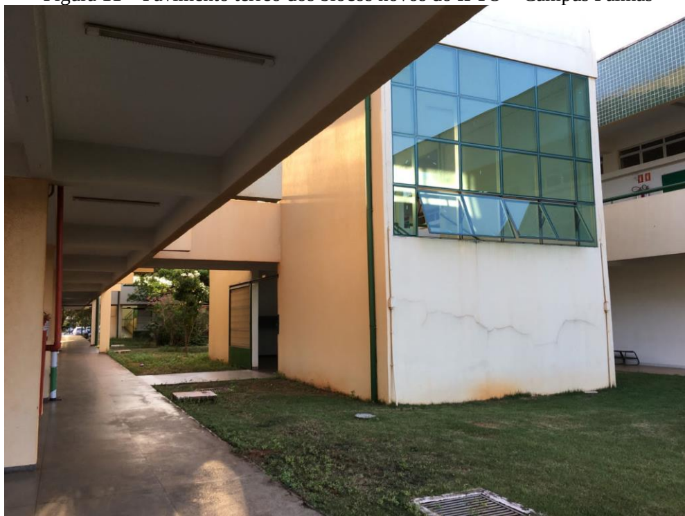
Figura 11 – Pavimento térreo dos blocos novos do IFTO – Campus Palmas
