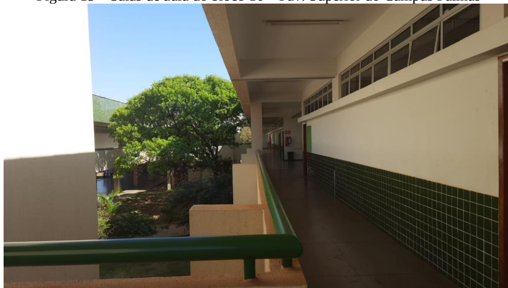
Figura 15 – Salas de aula do bloco 16 – Pav. Superior do Campus Palmas
