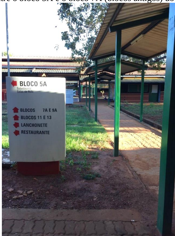
Figura 8 – Passarela entre o bloco 5A e o bloco 7A (blocos antigos) do IFTO – Campus Palmas
