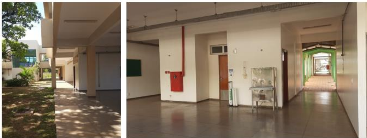
Figura 12 – Circulação e Banheiros dos blocos 16 e 17 respectivamente, Pav. Térreo - Campus Palmas
