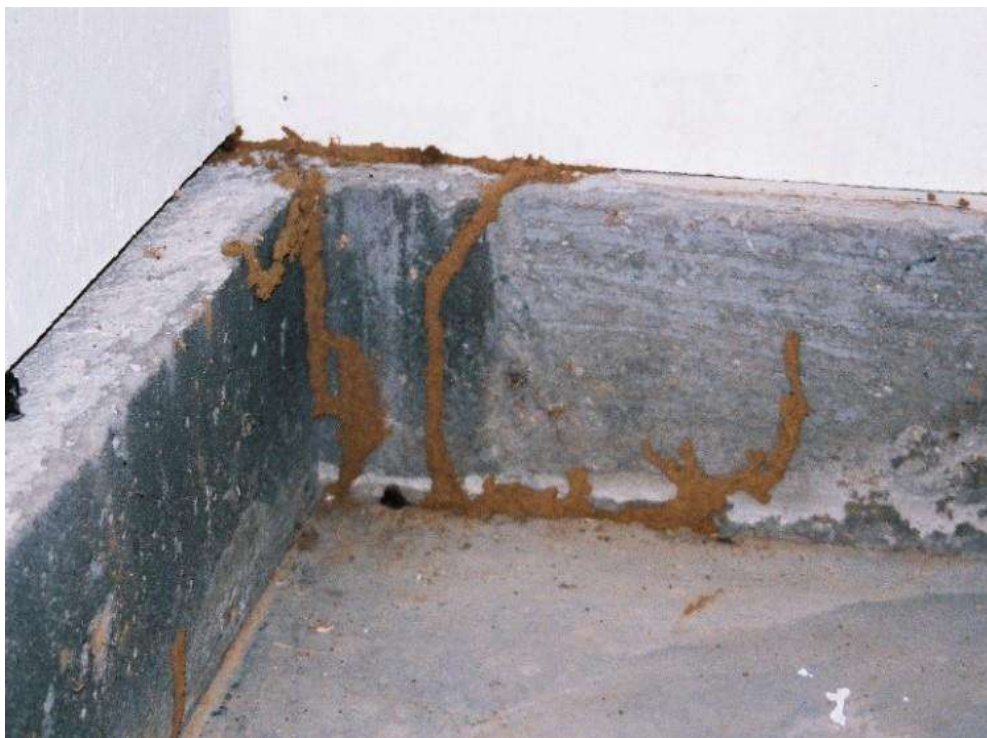
Figura 08 - Cupins de Solo
