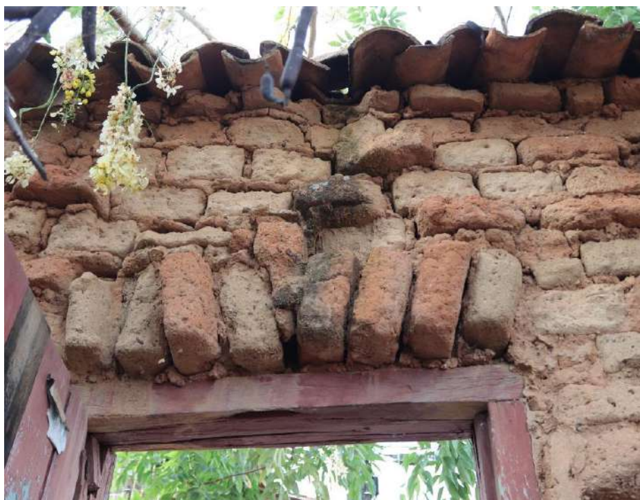
Figura 17 – Blocos na horizontal para aliviar as padieiras
