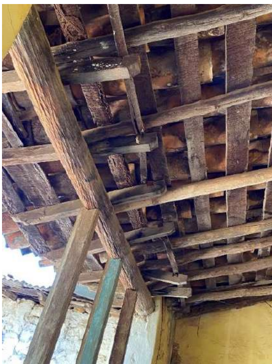
Figura 73 – Concentração de carga
