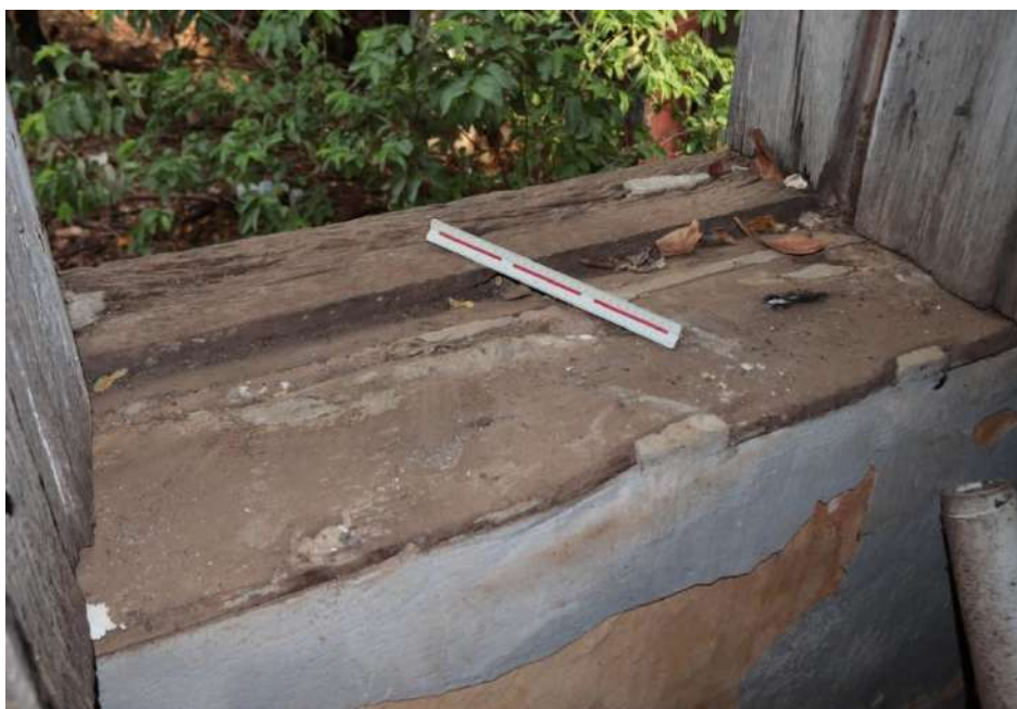
Figura 14 – Espessura da parede da edificação estudada
