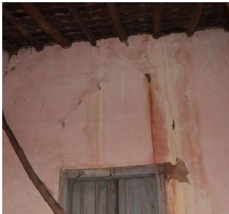
Figura 65 – Fissura
