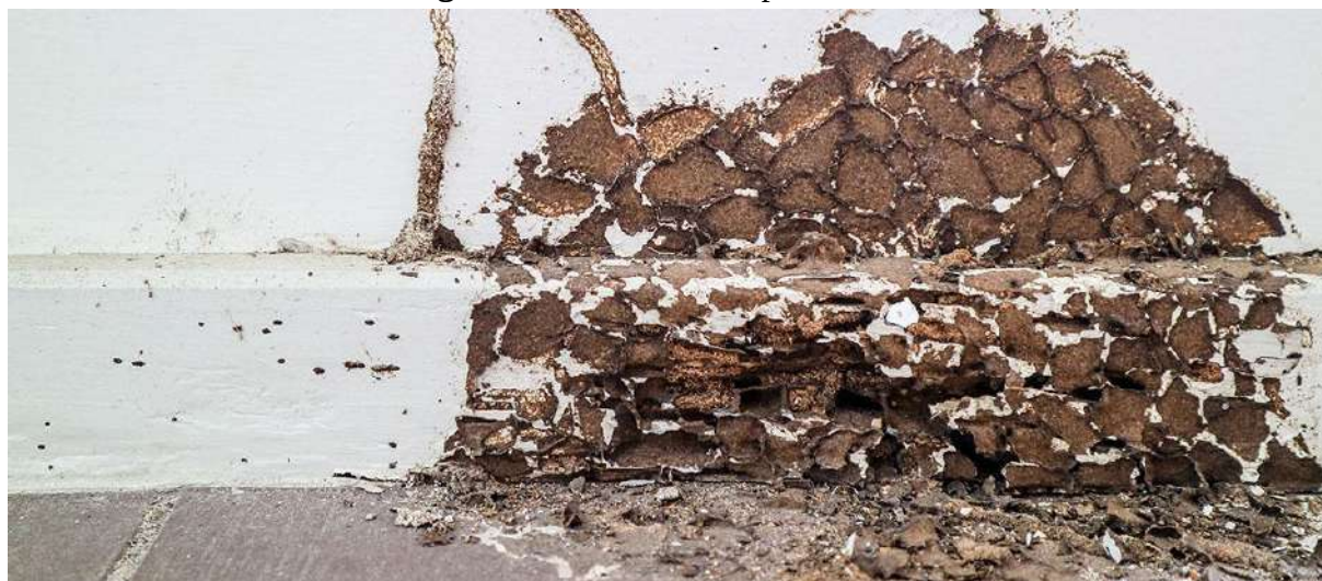
Figura 8.1 – Possível Cupins de Solo
