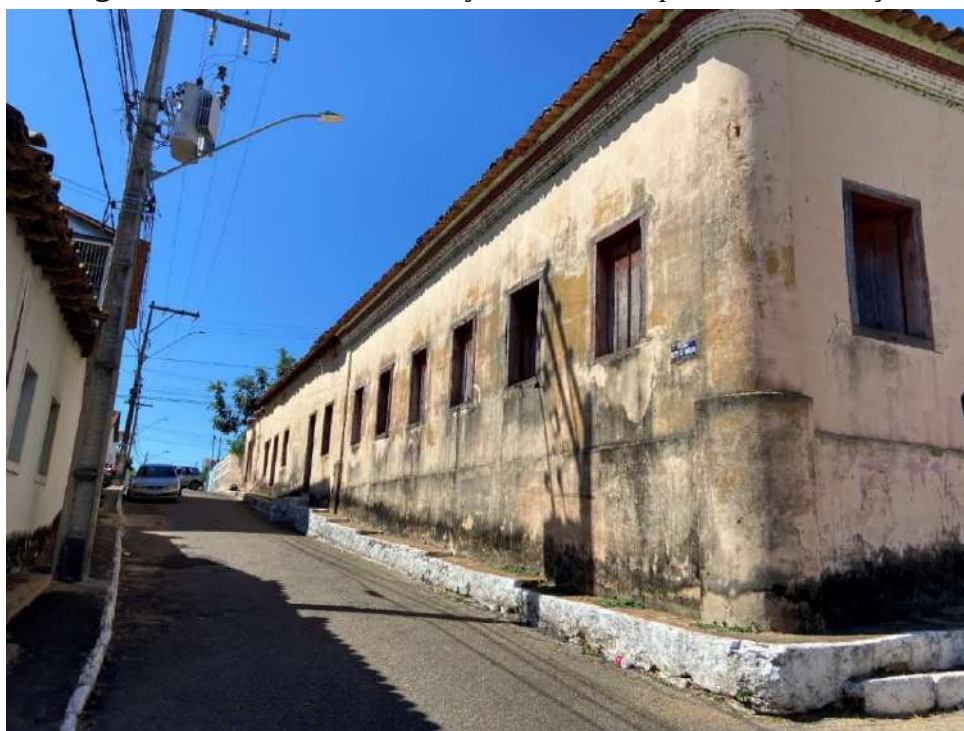
Figura 15.1 – Detalhe da cornija na lateral esquerda da edificação
