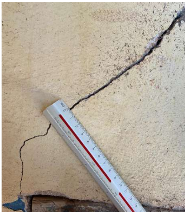
Figura 72 – Rachadura
