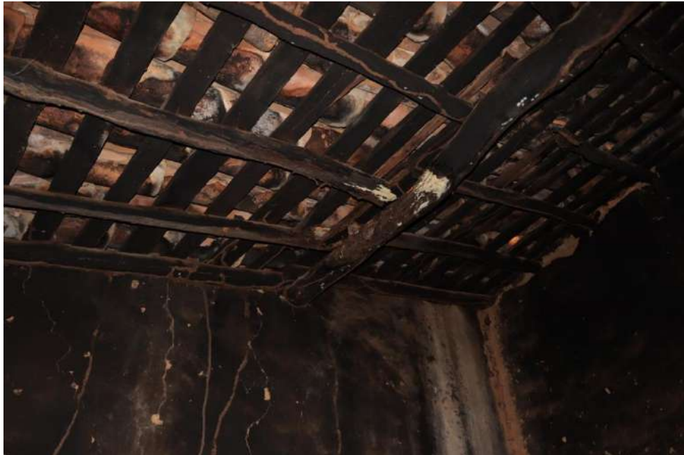
Figura 82 – Deformação excessiva
