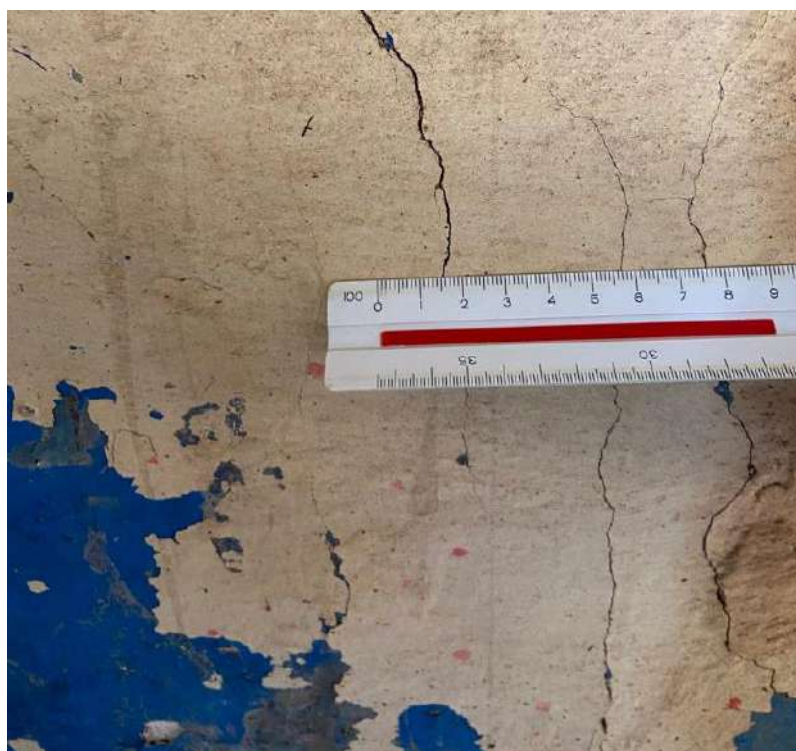
Figura 35 – Fissuras
