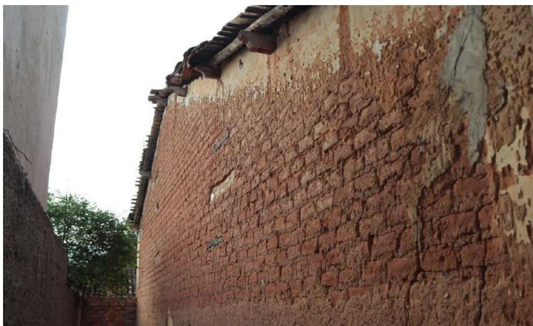
Figura 28.1 – Detalhe da parede lateral direita da casa grande
