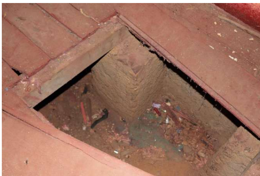
Figura 16.1 – Pilar localizado no quarto 2 da edificação
