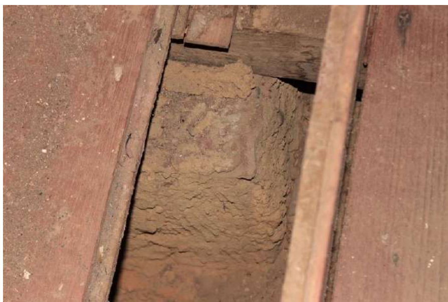
Figura 16 – Pilar localizado no quarto 1 da edificação
