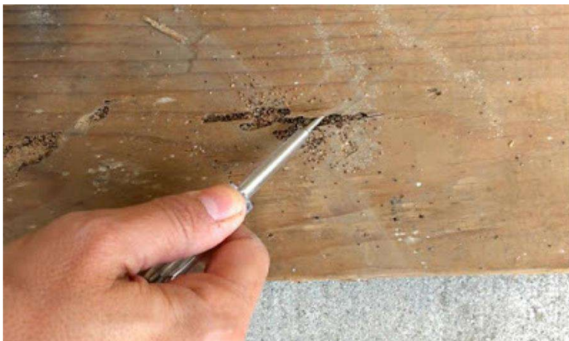
Figura 8.2 - Possível Cupins de Madeira
