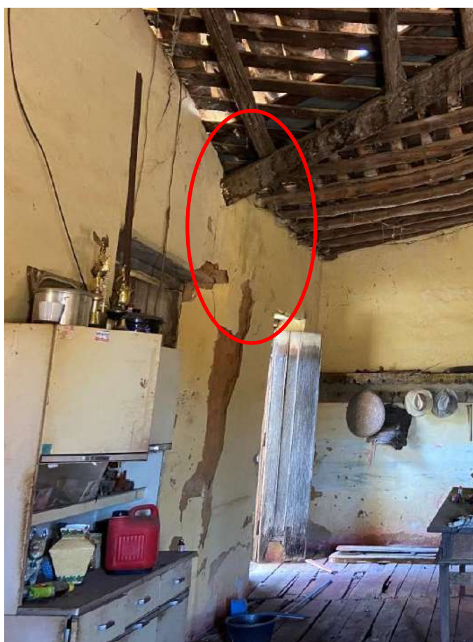
Figura 52 – Concentração de carga
