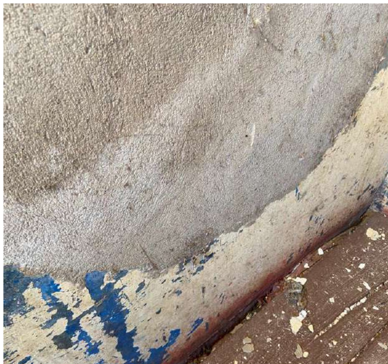
Figura 36 – Intervenção com preenchimento de cimento
