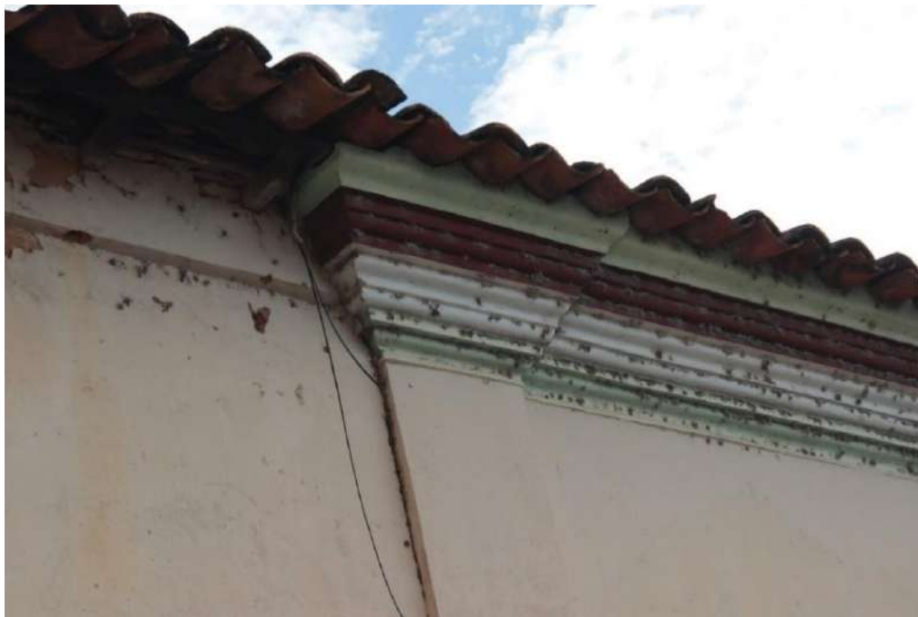
Figura 15 – Detalhe da cornija na edificação
