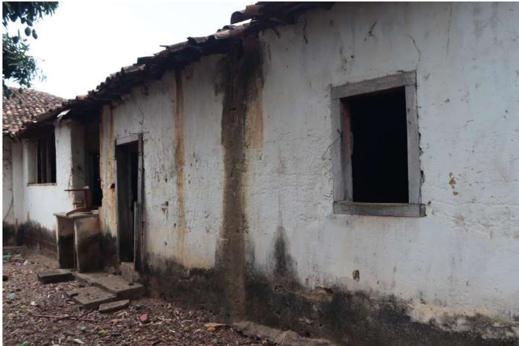
Figura 29.1 – Parede da senzala do lado direito da edificação
