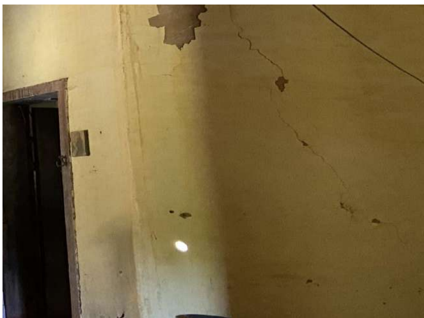
Figura 47 – Fissura
