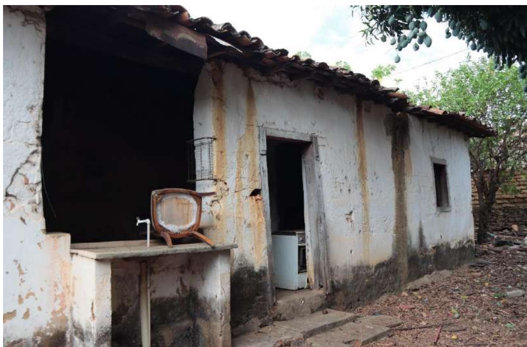
Figura 29 – Parede da senzala do lado direito da edificação
