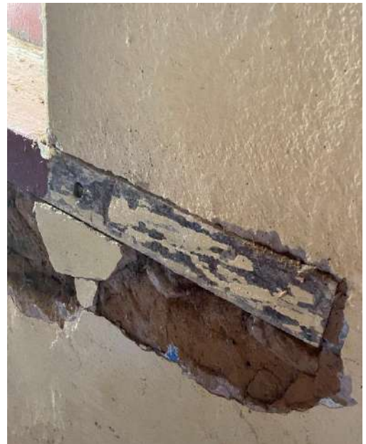
Figura 42.3 – Desplacamento
