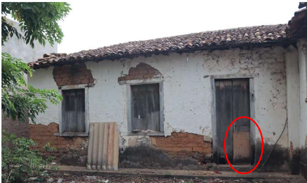
Figura 27 – Fundo da casa grande da edificação
