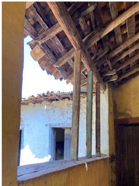
Figura 73.1 – Concentração de carga
