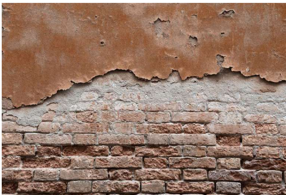
Figura 06 - Resgate de uma parede com infiltração
