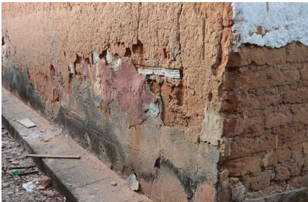
Figura 28.2 – Detalhe da parede lateral direita com intervenção de cimento
