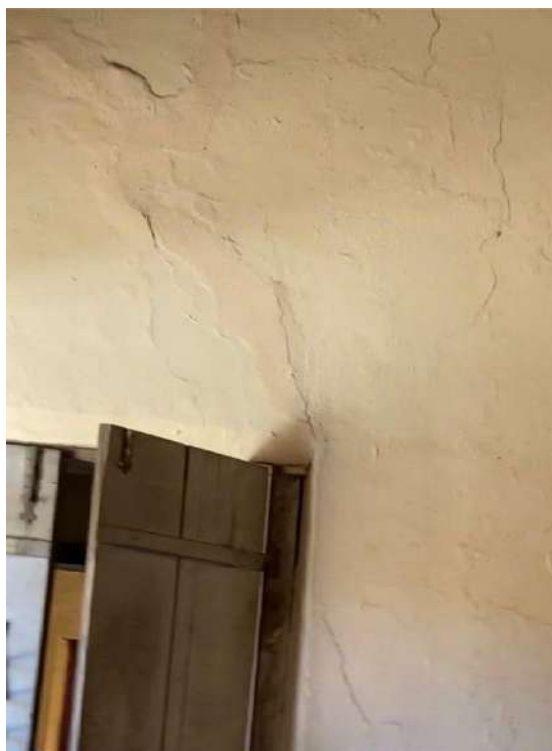
Figura 40 – Fissura
