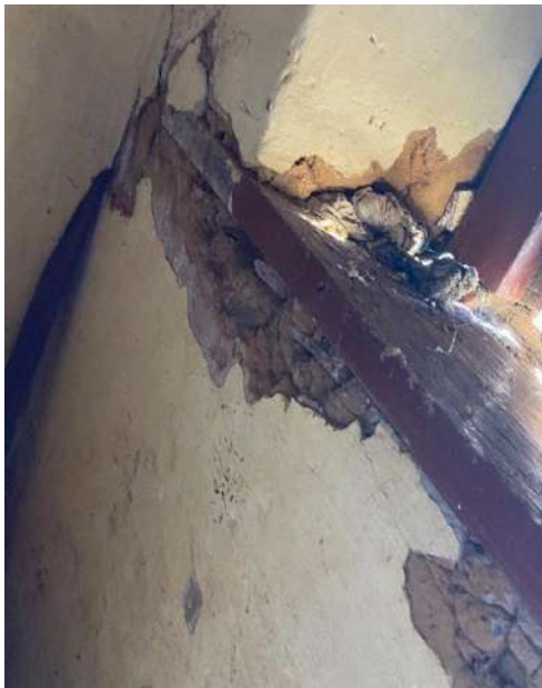
Figura 42.2 – Desplacamento
