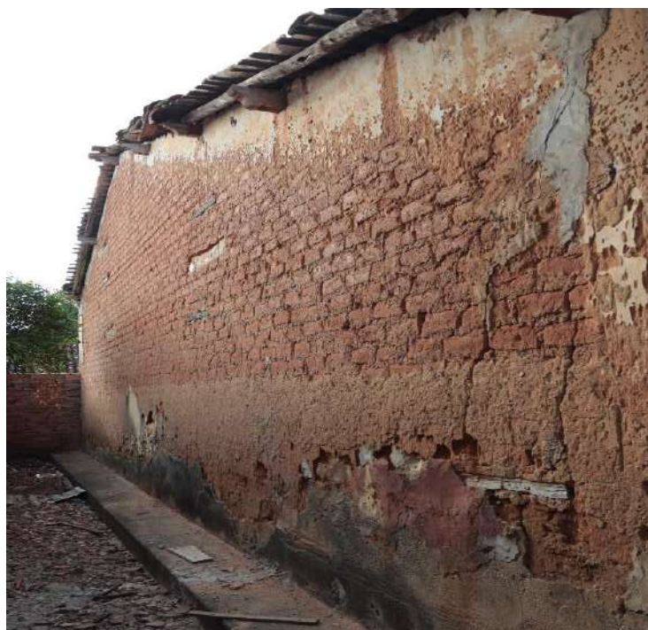
Figura 28 – Parede da lateral direita da casa grande
