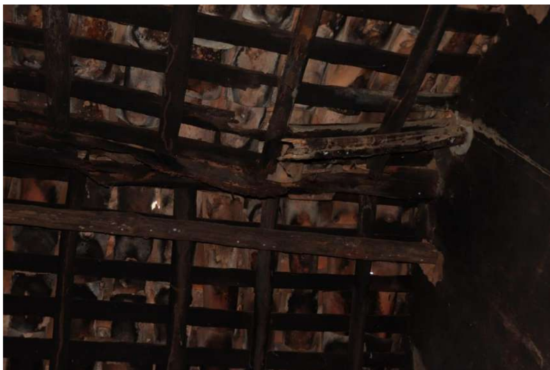
Figura 80 – Ruptura localizada do elemento
