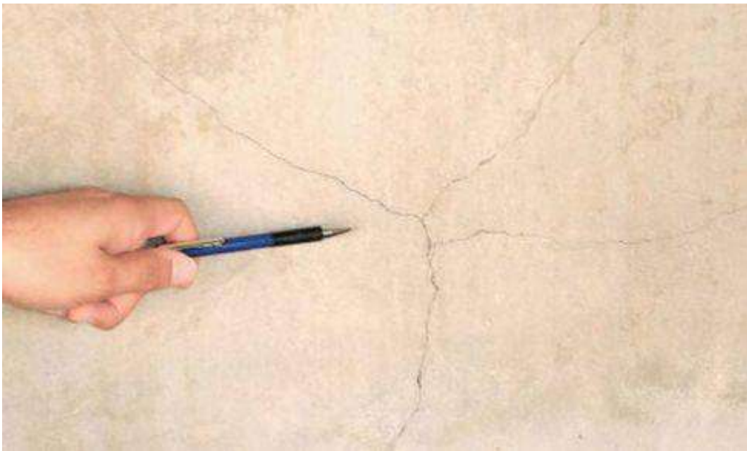
Figura 2.1 - Representação de fissura
