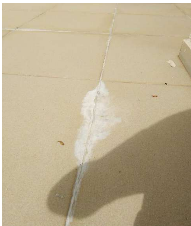
Figura 5.3 - Eflorescência em Rejuntamento de Piso
