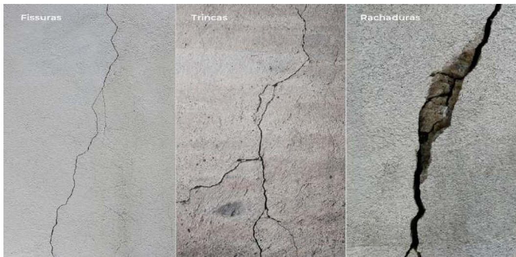
Figura 02 - Representação de fissura, trincas e rachaduras
