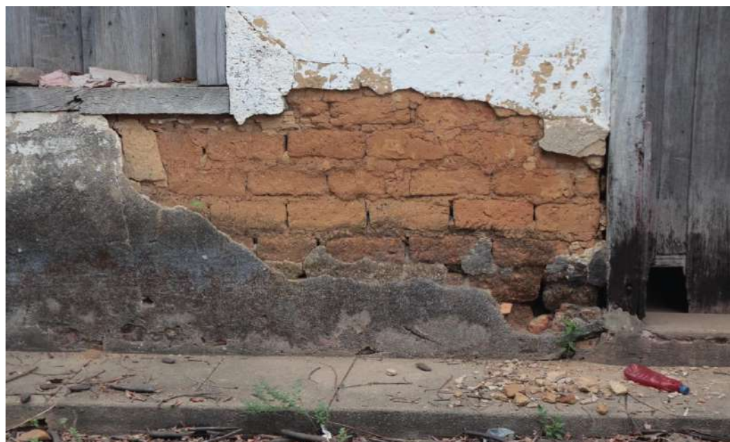
Figura 27.3 – Intervenção com preenchimento de cimento
