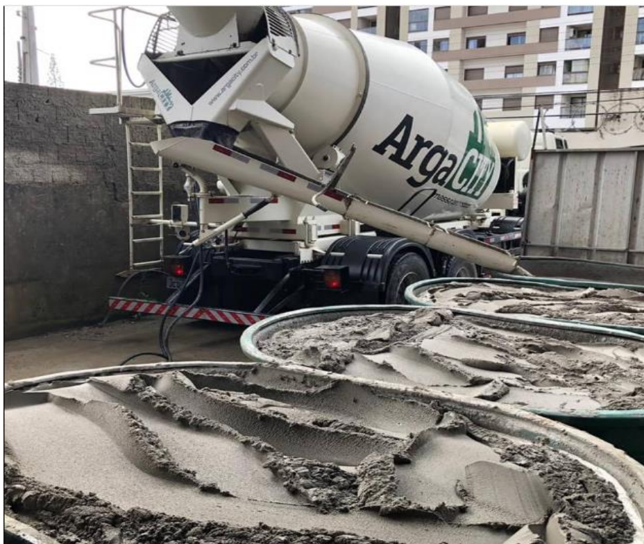
Figura 1 - Caminhão despejando a argamassa nas caixas.
