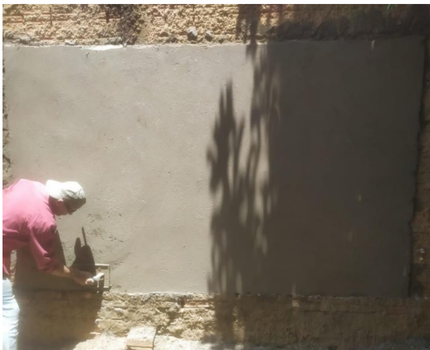
Figura 11 - Execução de reboco
