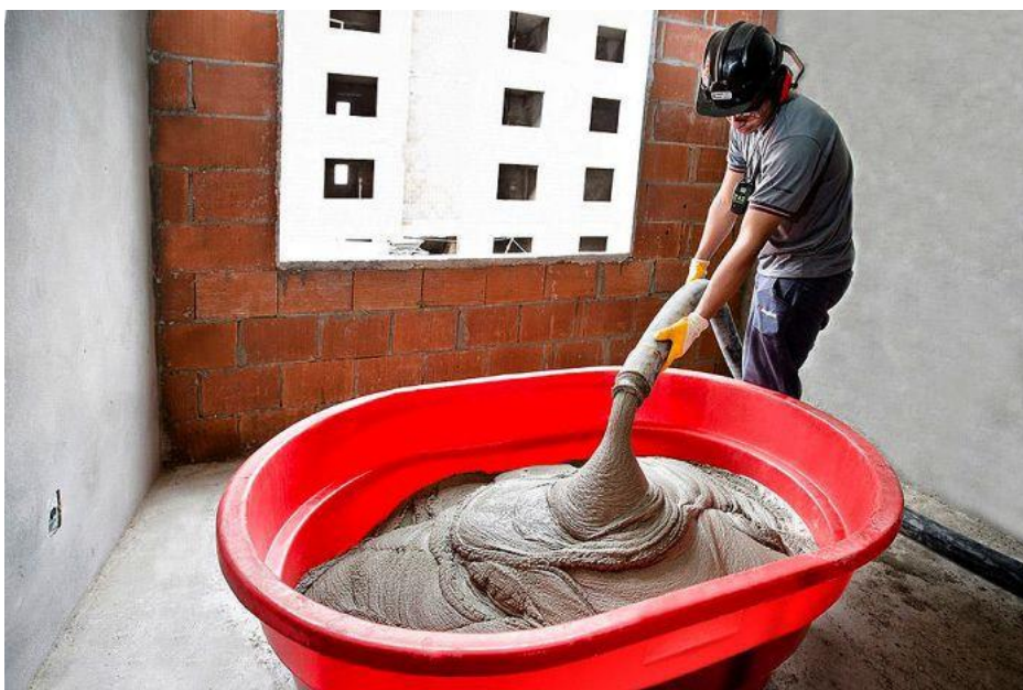
Figura 2 - Bomba despejando a argamassa na caixa plástica
