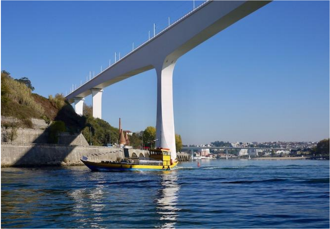
Figura 8: Ponte São João (Portugal) – Exemplo de ponte em pórtico
