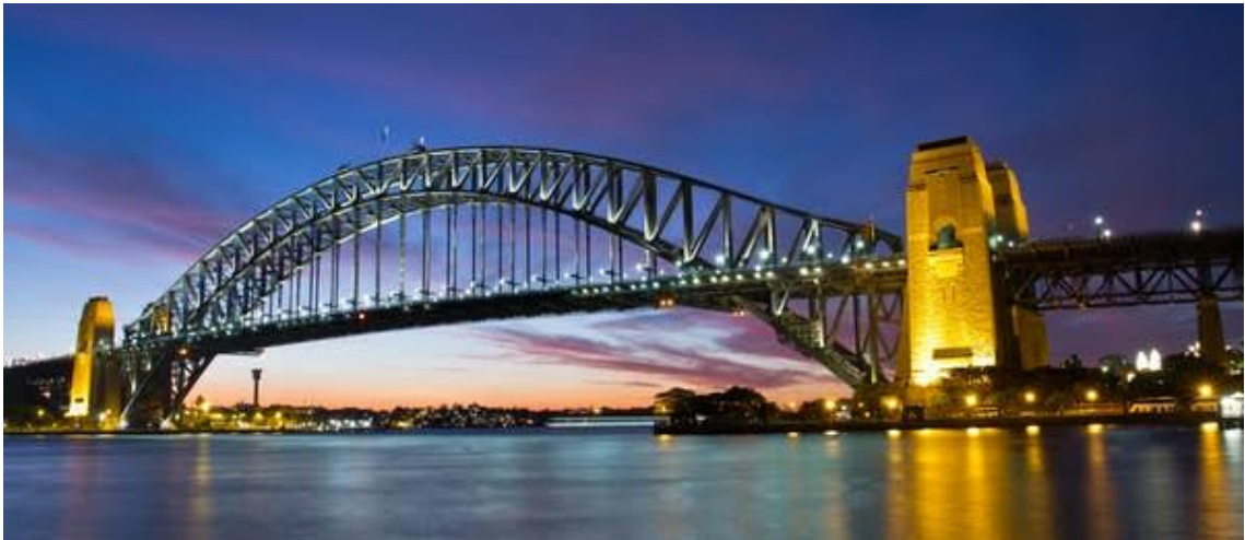
Figura 9: Ponte São João (Austrália) – Exemplo de ponte em arco
