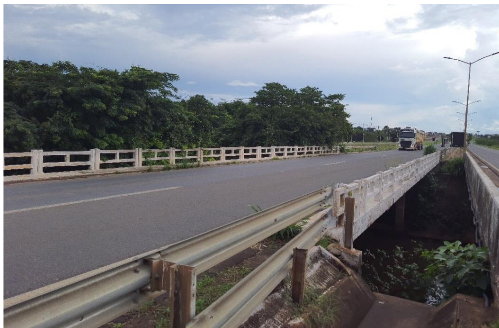
Figura 25: Vista da saída da ponte analisada
