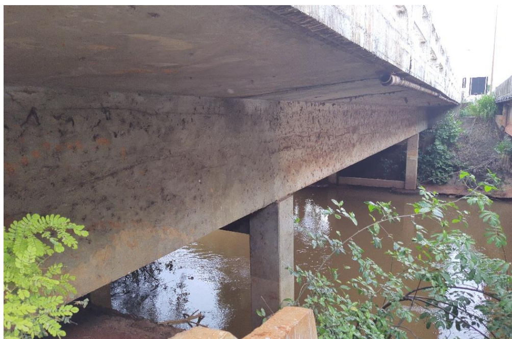
Figura 26: Vista da estrutura da ponte analisada
