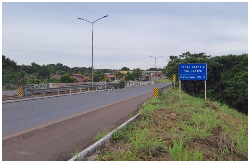
Figura 24: Vista da entrada da ponte analisada
