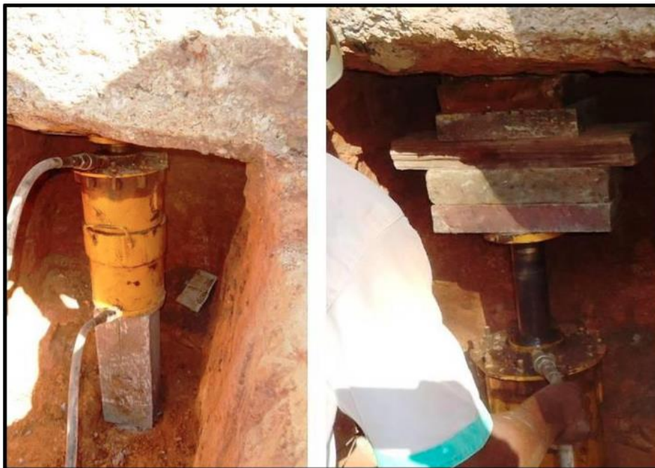
Figura 78 – Execução de estacas mega através da prensagem por pistão
