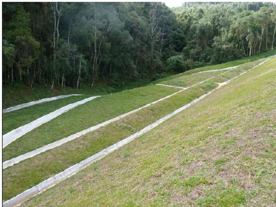
Figura 21– Retaludamento de terreno íngreme
