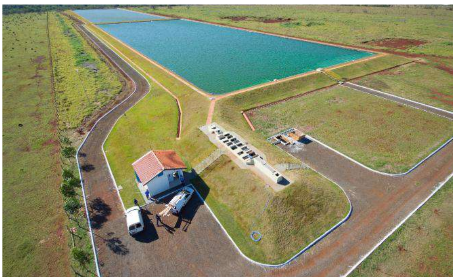
Figura 11– Tratamento de esgoto com lagoa facultativa
