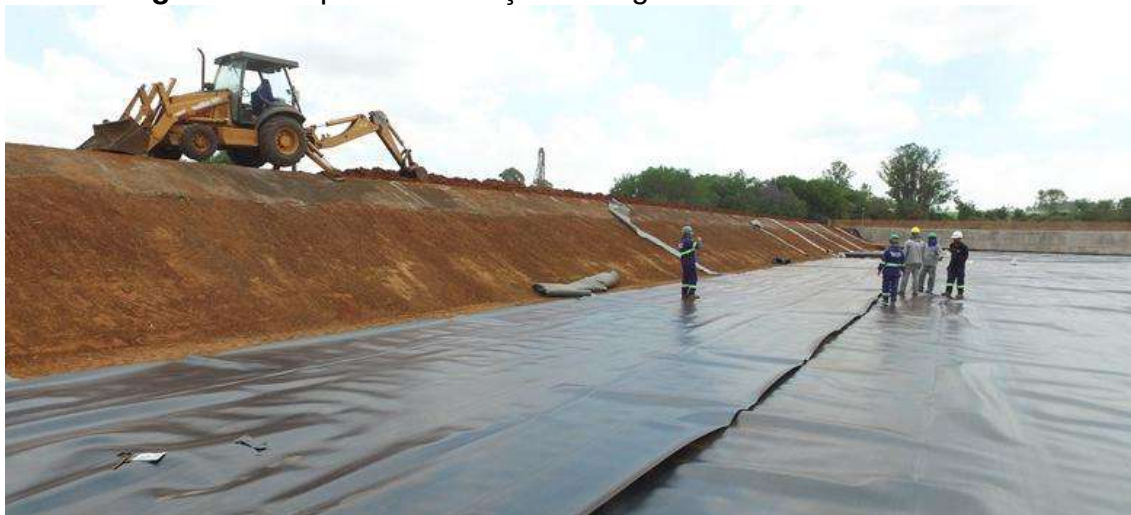
Figura 50- Impermeabilização com geomembrana PEAD 2 mm
