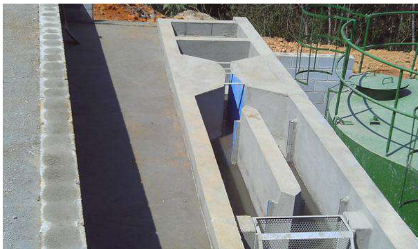
Figura 9 – Desarenador
