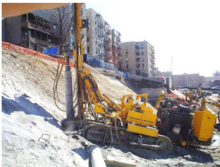
Figura 16– Perfuratriz hidráulica
