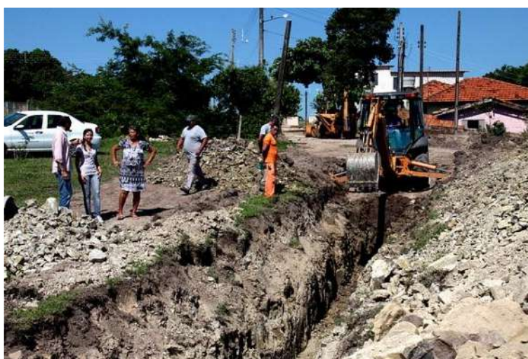
Figura 14 – Retirada de solo rochoso após desmonte
