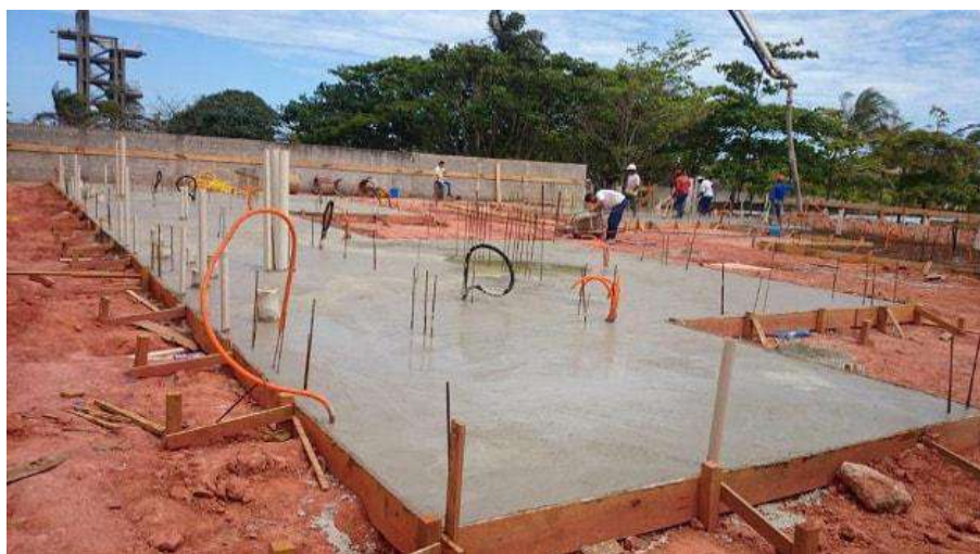
Figura 41- Fundação em radier
