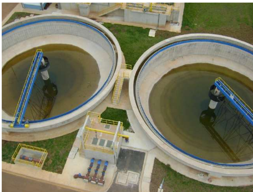
Figura 10 – Decantador primário
