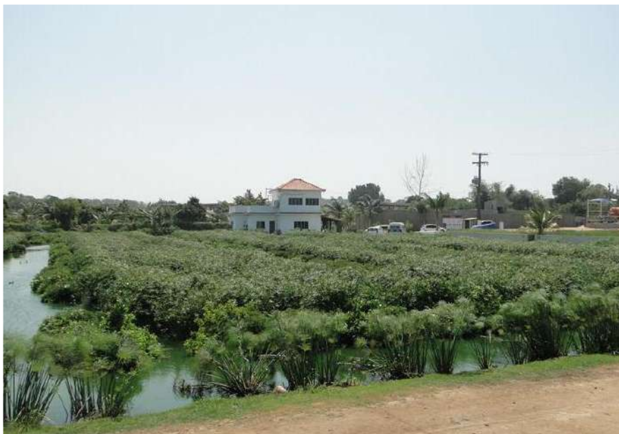
Figura 12– Tratamento de esgoto com plantas aquáticas
