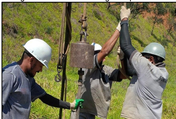
Figura 1 - Martelo - sondagem a percussão
