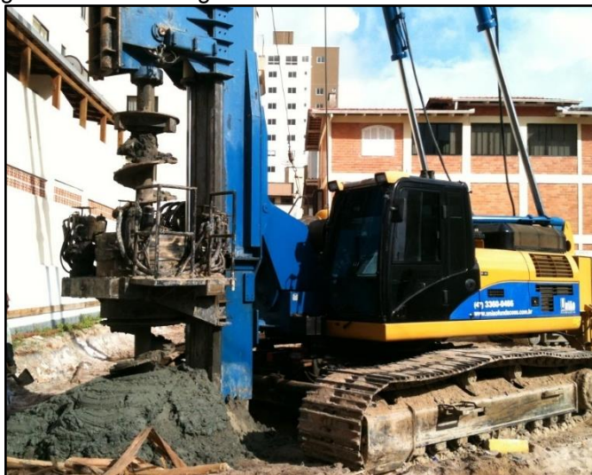
Figura 12 - Concretagem - estaca hélice contínua monitorada
