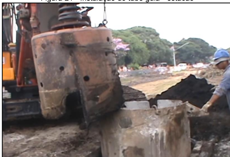
Figura 21 - Instalação do tubo guia - estação
