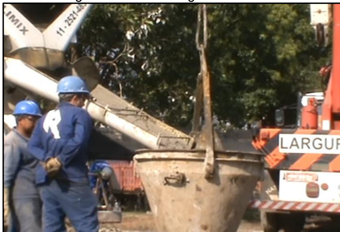
Figura 24 - Concretagem de estacão
