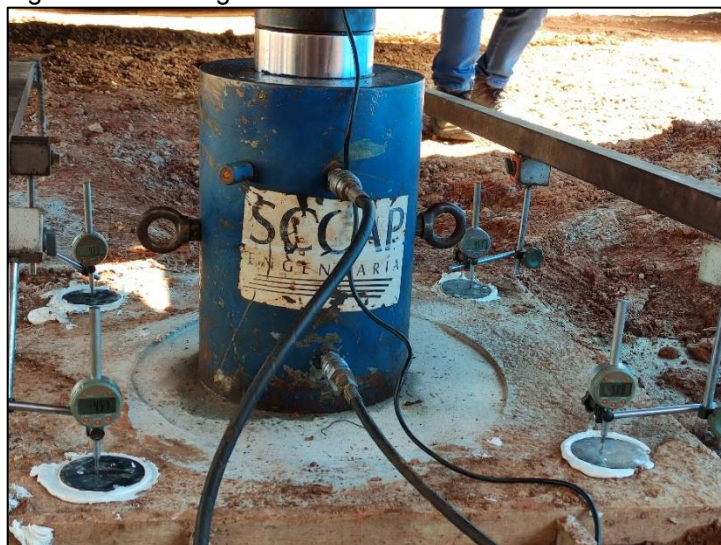
Figura 56 - Montagem de macaco hidráulico e extensômetros
