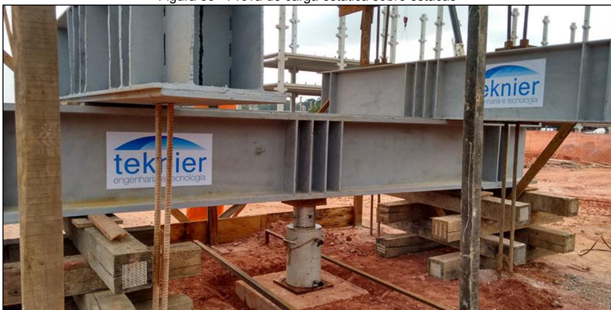
Figura 33 - Prova de carga estática sobre estacas
