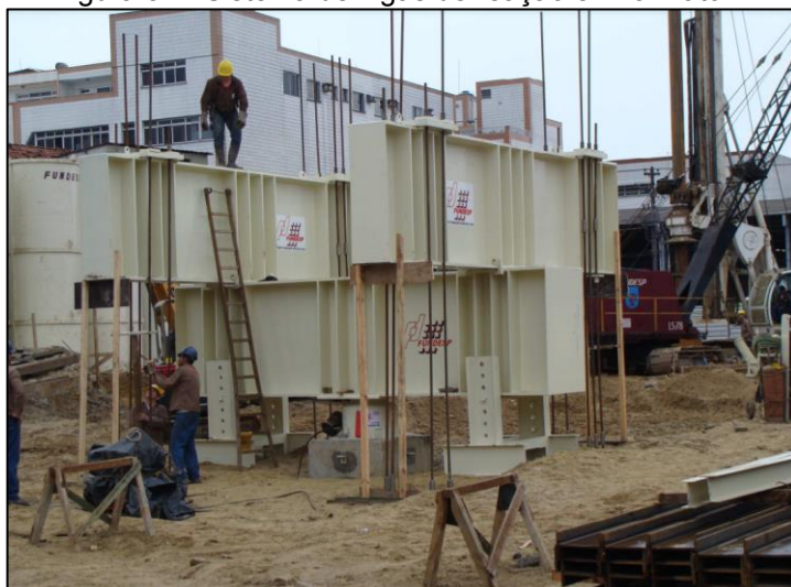
Figura 32 - Sistema de vigas de reação em formato H
