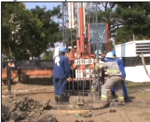
Figura 23 - Colocação da armadura - estação
