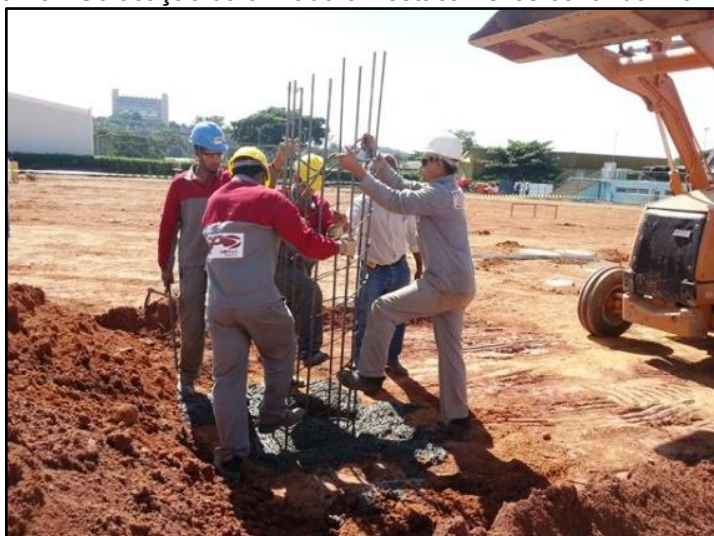
Figura 13 - Colocação da armadura - estaca hélice contínua monitorada
