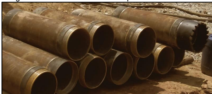
Figura 15 - Tubos metálicos recuperáveis - Estaca Raiz
