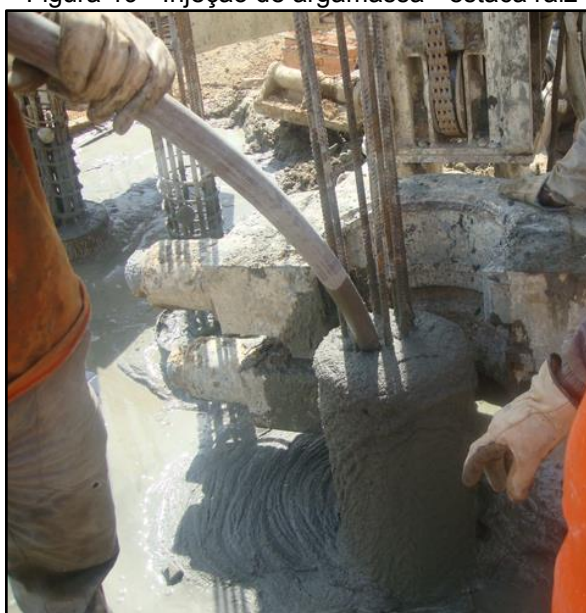
Figura 19 - Injeção de argamassa - estaca raiz
