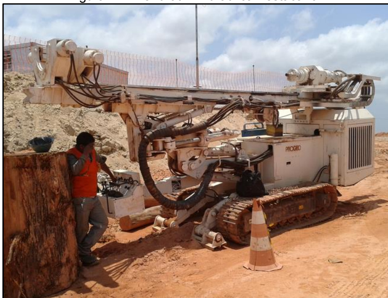
Figura 14 - Perfuratriz hidráulica - estaca raiz
