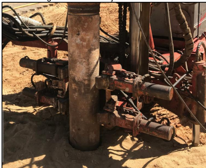
Figura 17 - Perfuração - estaca raiz
