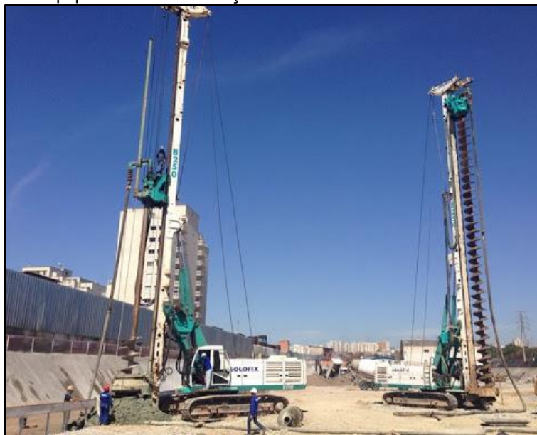
Figura 9 - Equipamento de execução de estacas Hélice Contínua Monitorada
