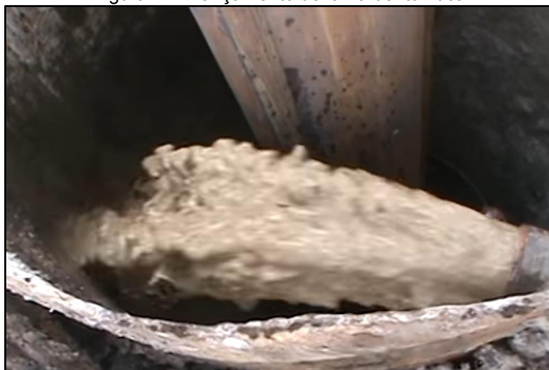
Figura 22 - Lançamento de lama bentonítica
