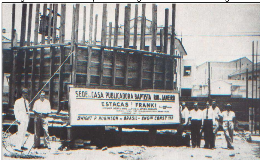
Figura 29 - Ensaio de prova de carga estática utilizando cargueiras
