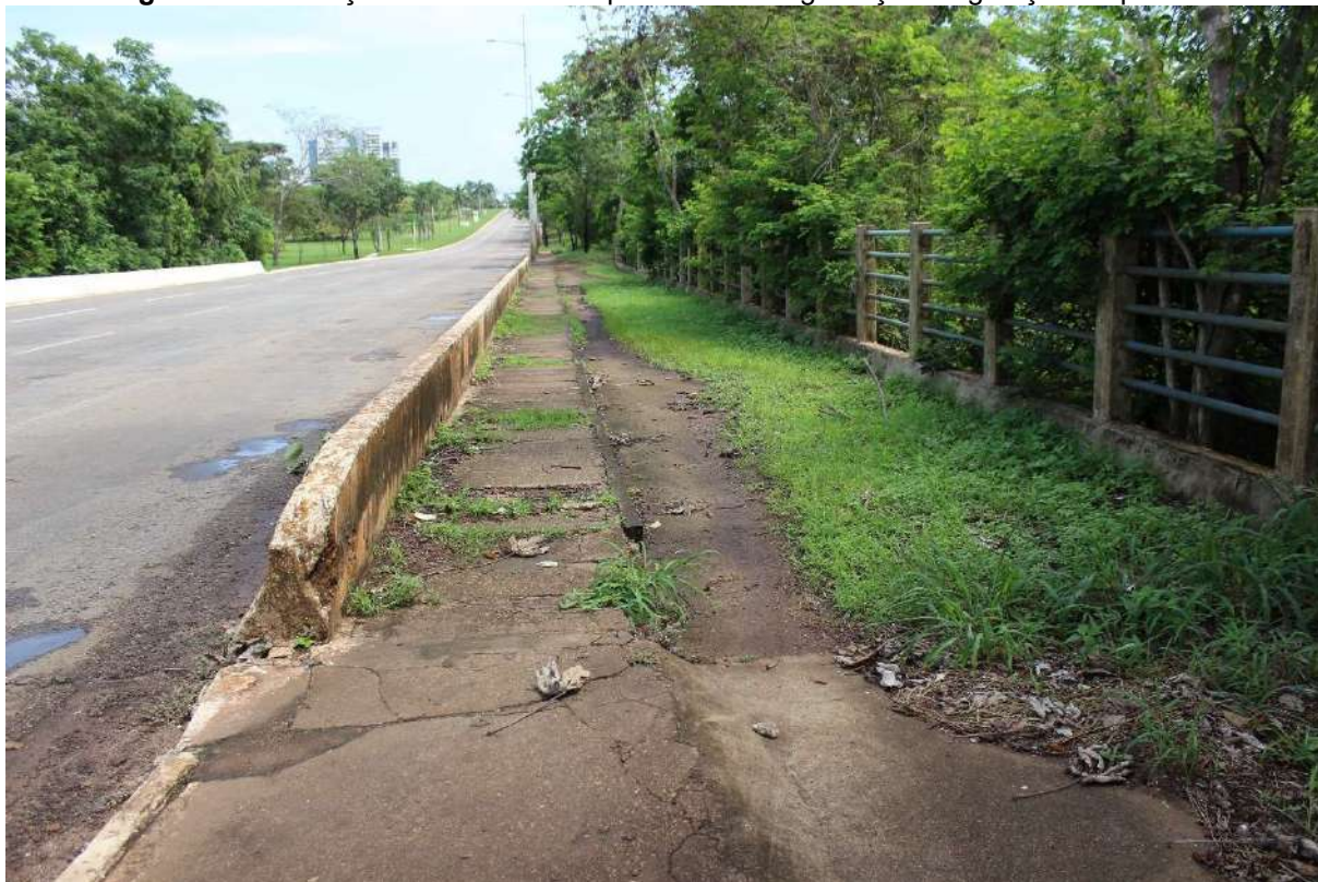
Figura 34: Formação de limos nos dispositivos de segurança e vegetação no passeio
