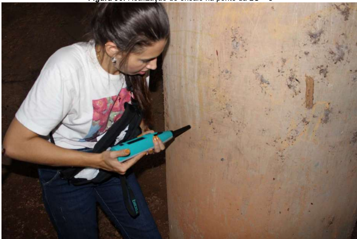
Figura 90: Realização de ensaio na ponte da LO – 5
