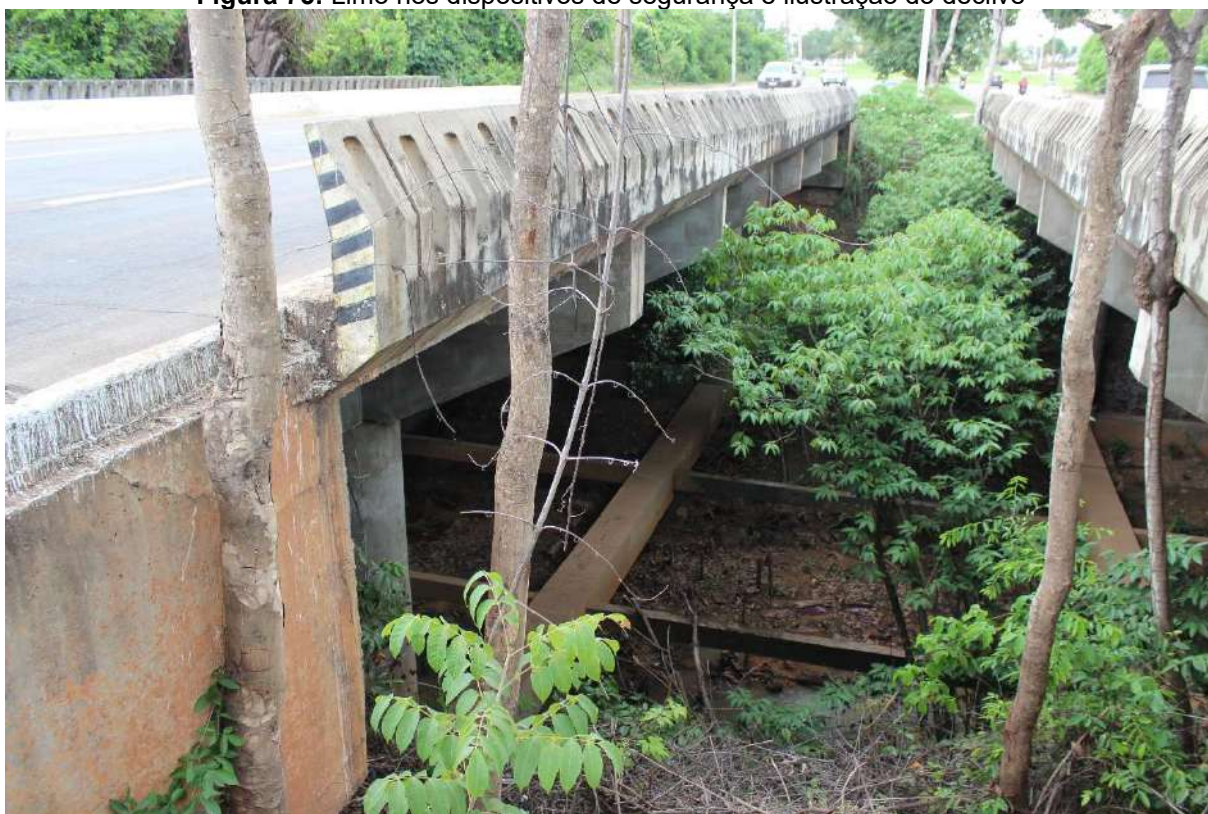
Figura 75: Limo nos dispositivos de segurança e ilustração do declive
