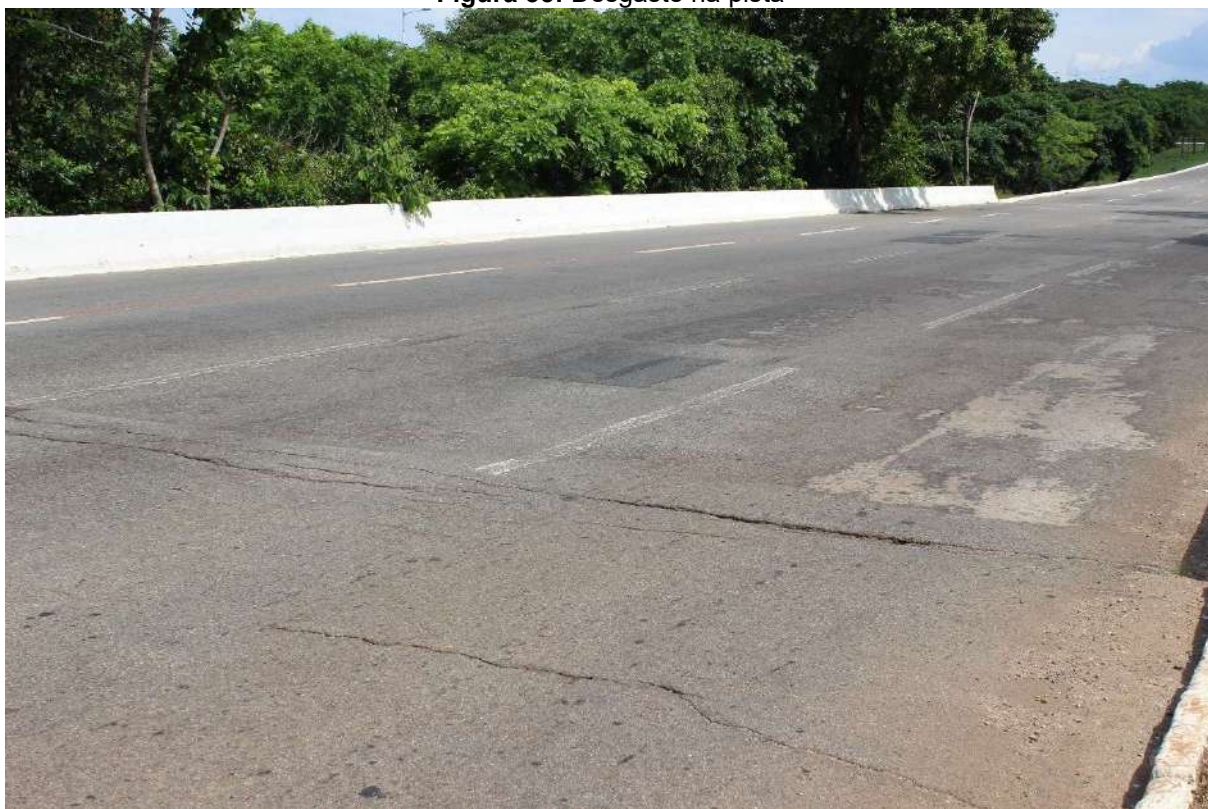
Figura 33: Desgaste na pista
