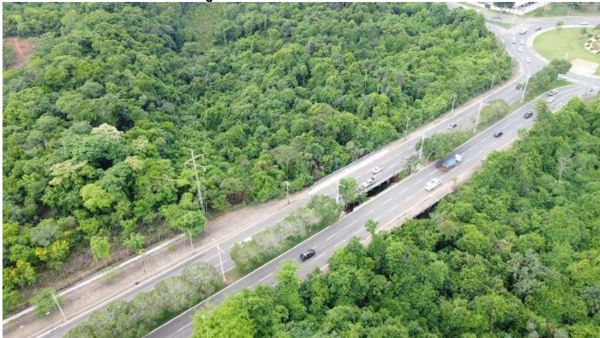
Figura 69: Pontes da Avenida NS - 2
