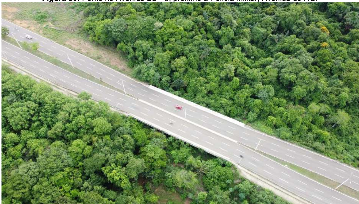
Figura 80: Ponte na Avenida LO - 5, próximo a Polícia Militar, Avenida do HGP
