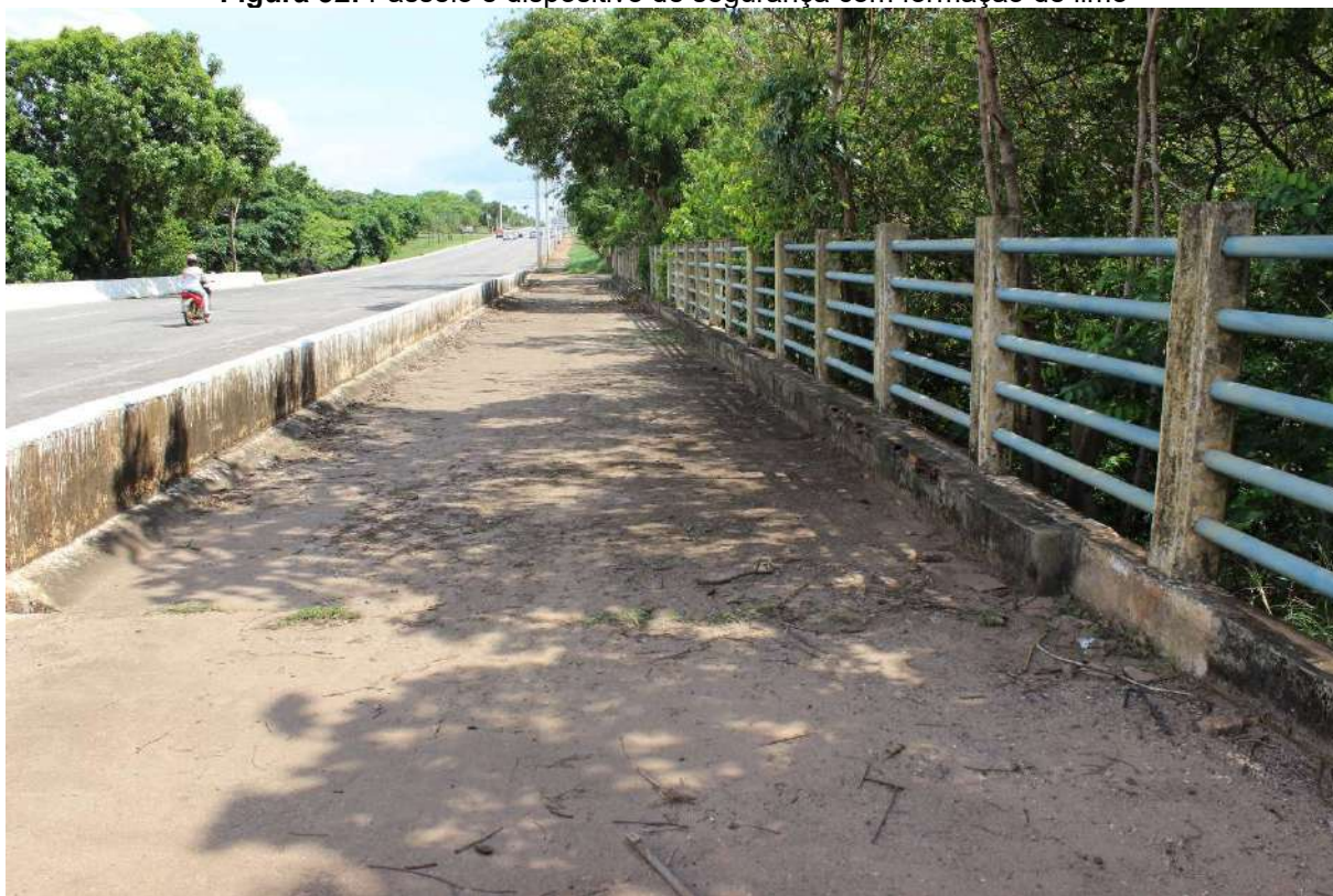
Figura 32: Passeio e dispositivo de segurança com formação de limo
