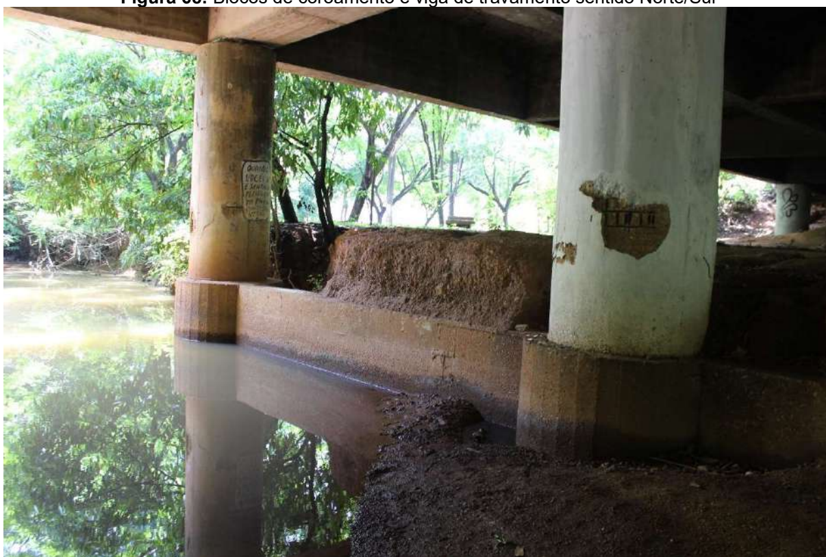
Figura 68: Blocos de coroamento e viga de travamento sentido Norte/Sul
