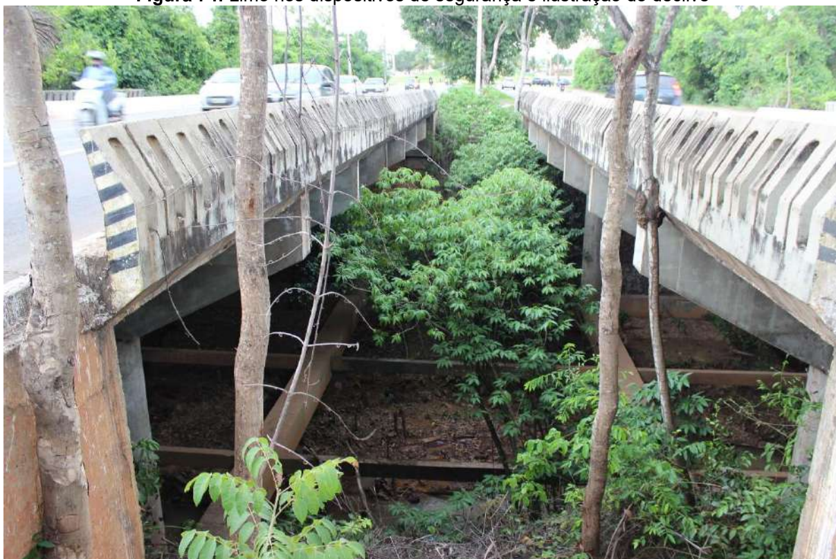
Figura 74: Limo nos dispositivos de segurança e ilustração do declive
