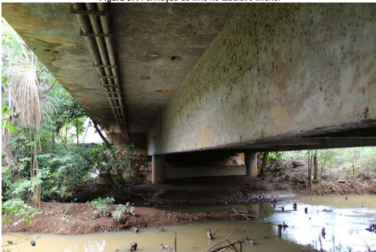
Figura 87: Formação de limo no tabuleiro inferior
