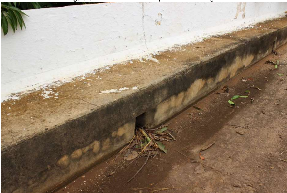
Figura 82: Folhas secas nos dispositivos de drenagem
