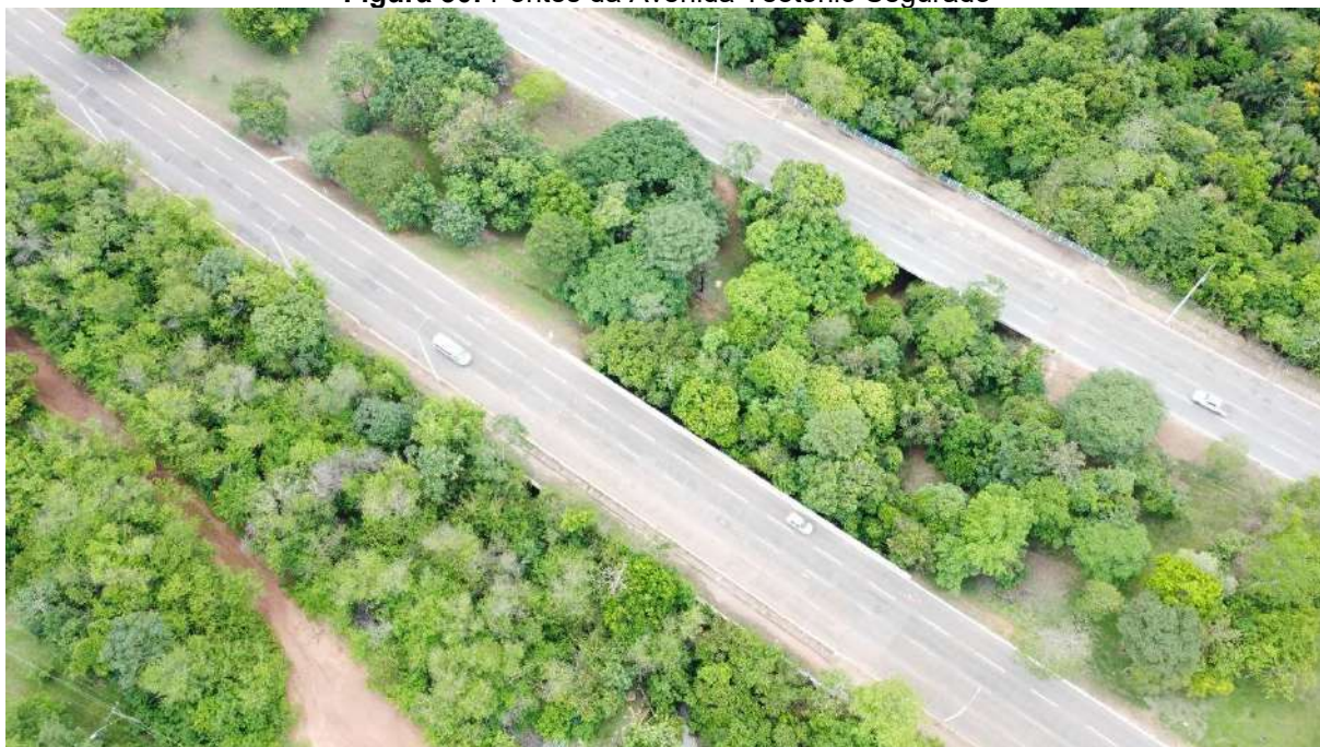
Figura 30: Pontes da Avenida Teotônio Segurado
