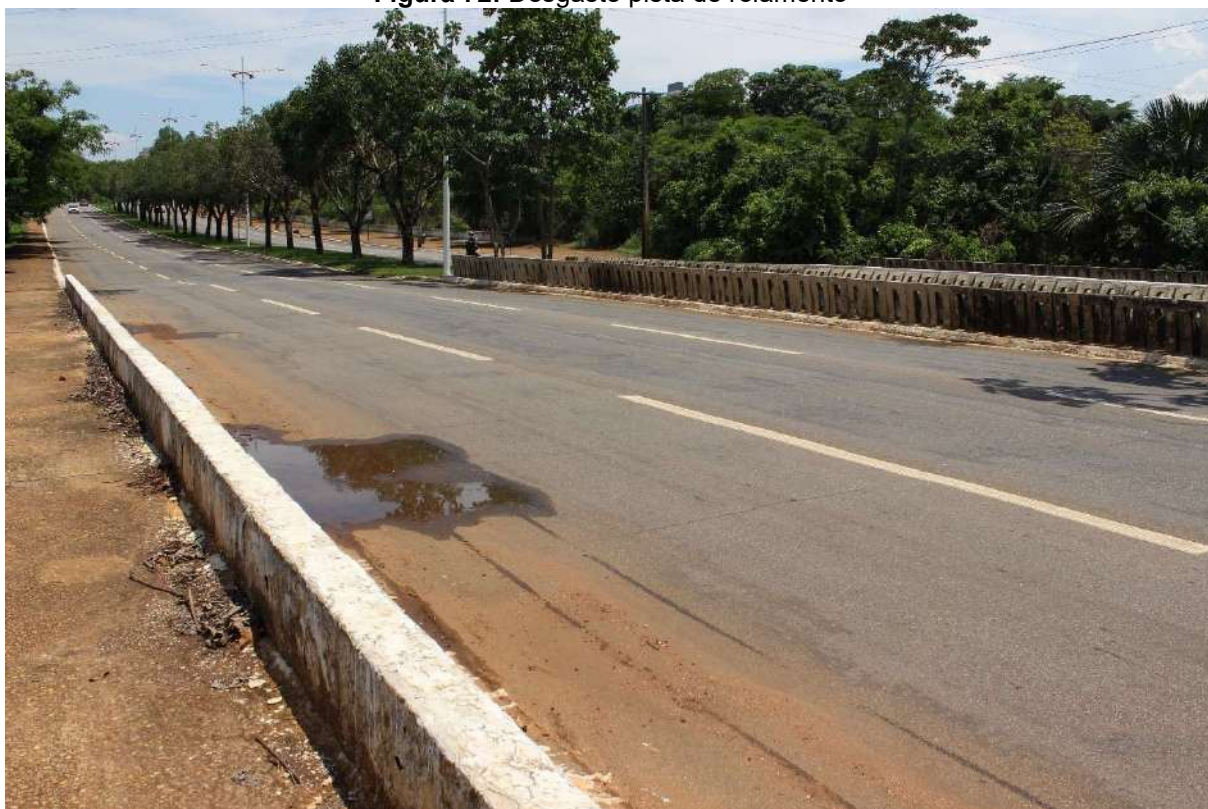
Figura 72: Desgaste pista de rolamento
