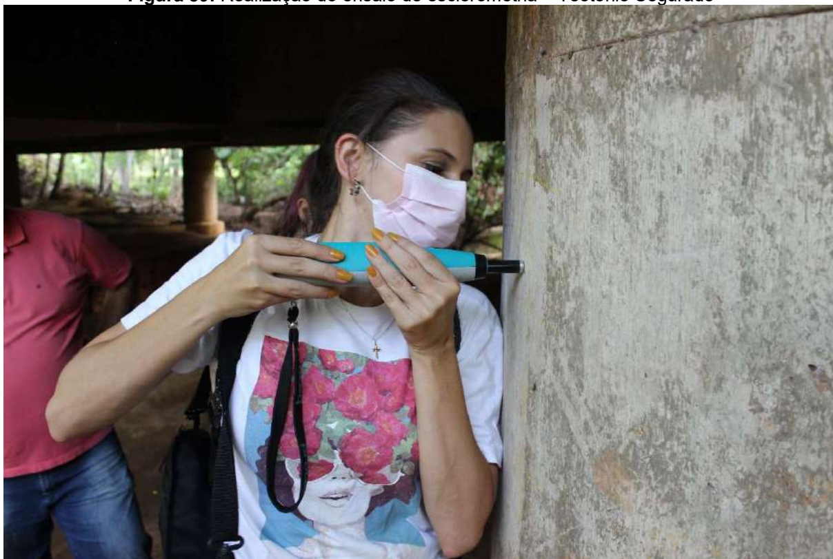
Figura 89: Realização do ensaio de esclerometria – Teotônio Segurado
