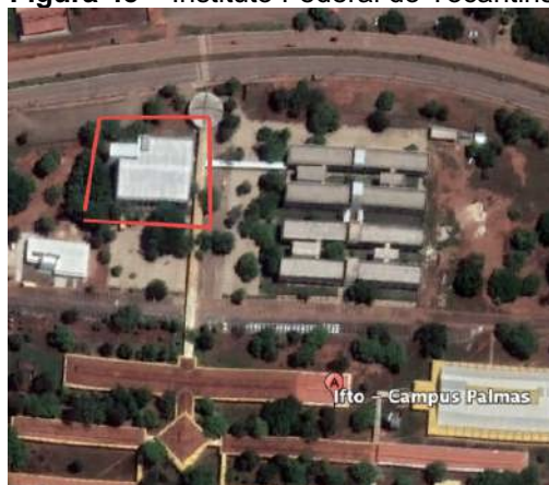
Figura 45 – Instituto Federal do Tocantins
