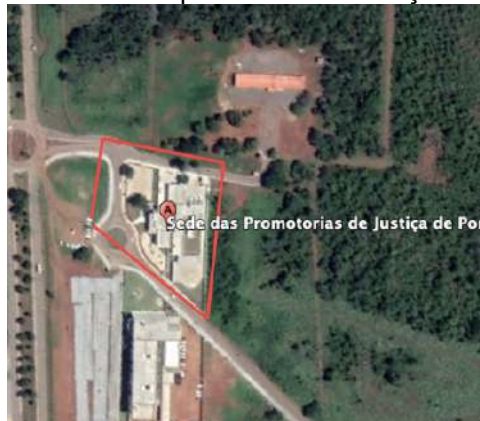
Figura 47 – Prédio Sede da promotoria de Justiça de Porto Nacional
