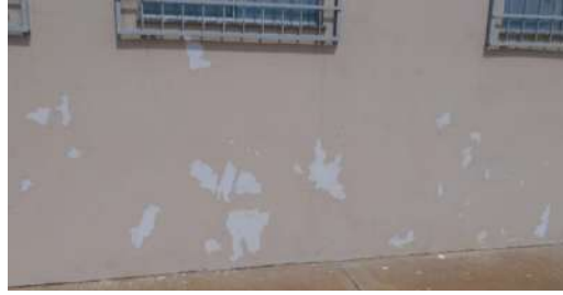
Figura 6 – Pintura descascando
