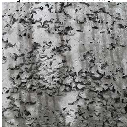
Figura 25 – Ninhos de concretagem
