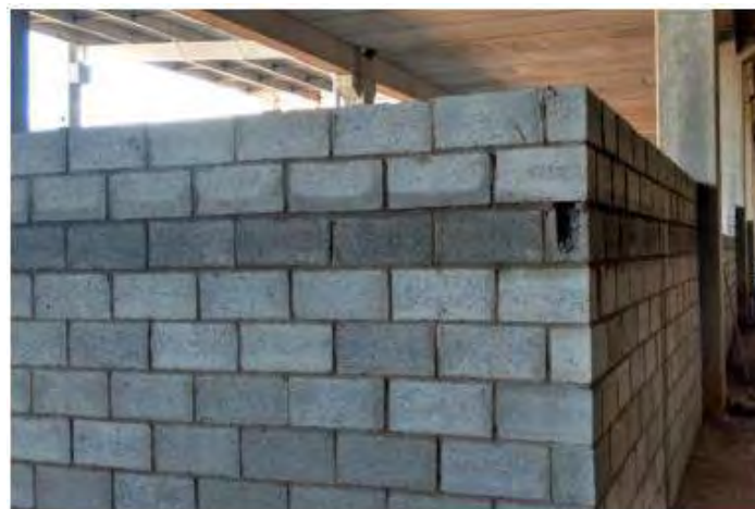
Figura 21-Alvenaria de vedação em bloco de concreto
