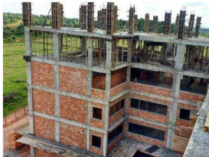
Figura 20-Construção de edifício utilizando alvenaria de vedação em bloco cerâmico
