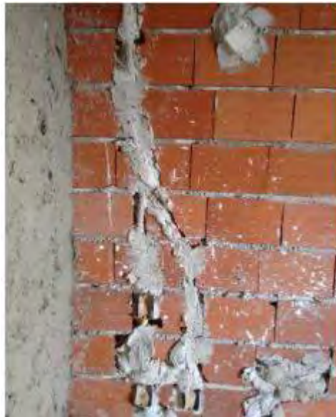
Figura 22-Cortes em alvenaria tradicional para passagem de dutos
