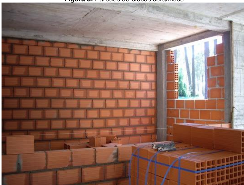
Figura 3: Paredes de blocos cerâmicos
