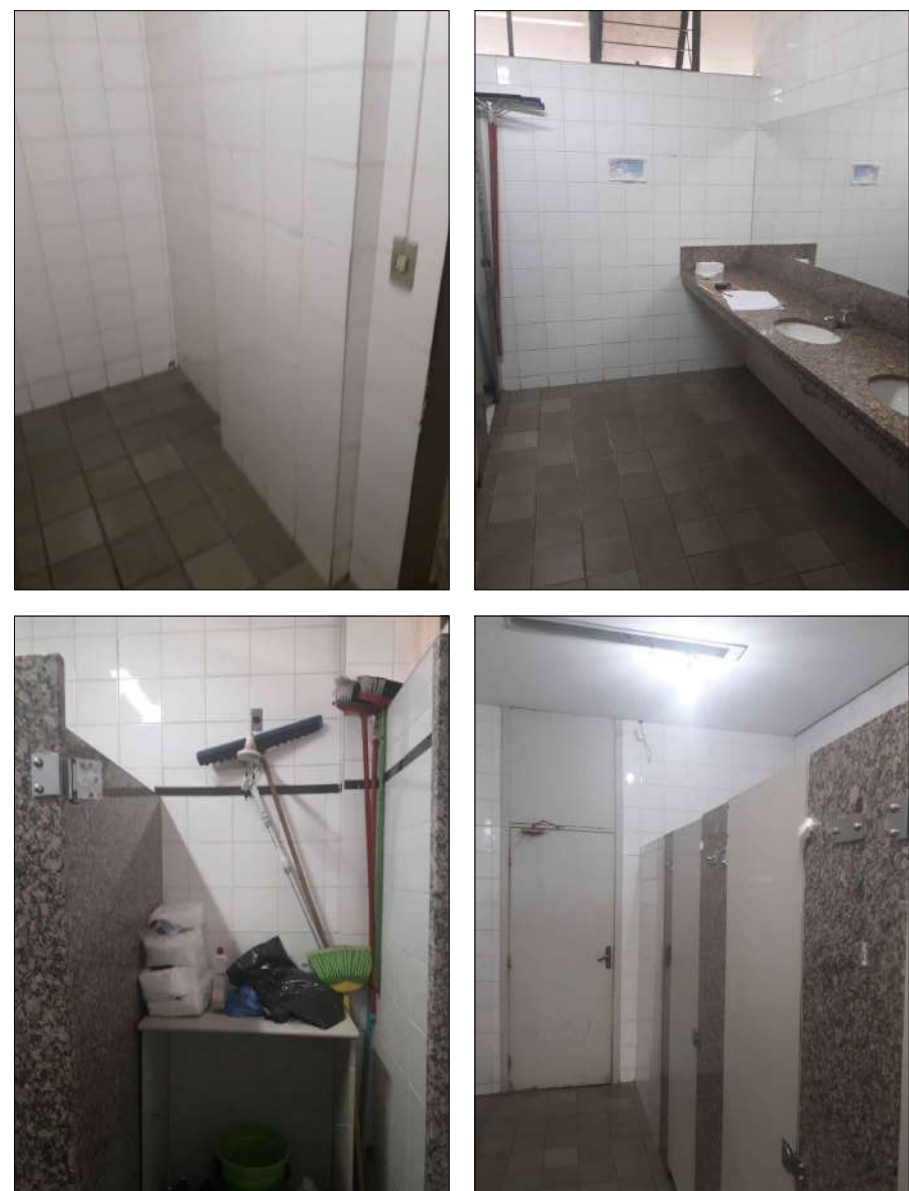
IMAGENS DO SANITÁRIO EXISTENTE
