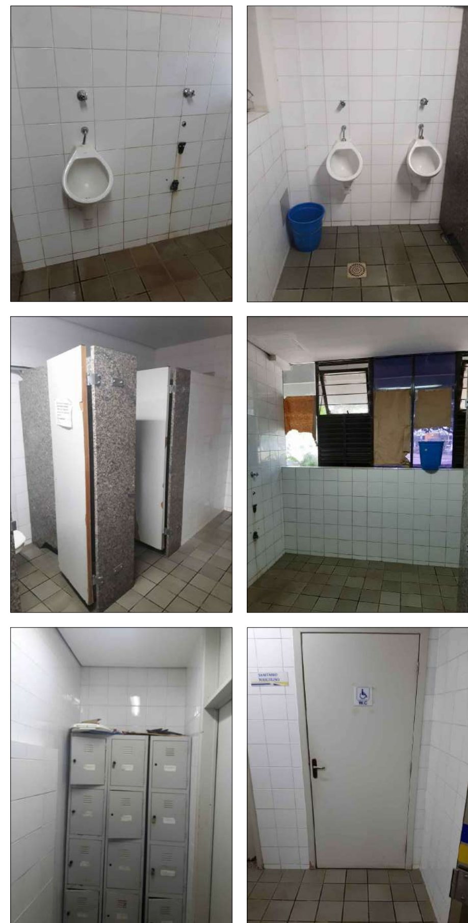
IMAGENS DO SANITÁRIO EXISTENTE
