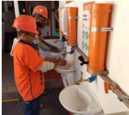
Figura 2: Lavatórios na entrada, no refeitório e vestiários
