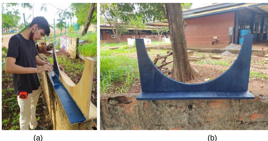
Figura 55 - (a) Pintura do material compensado, (b) 1º demão aplicada
