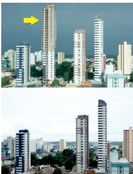
Figura 5 - Colapso do Edifício Real Class no Brasil
