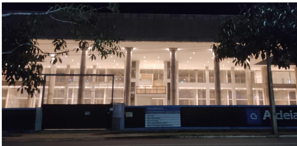
Figura 32 - Obra comercial com pilares circulares na fachada em Palmas-TO
