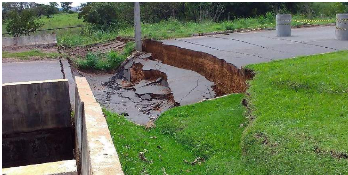
Figura 33 – Desmoronamento da cabeceira sul
