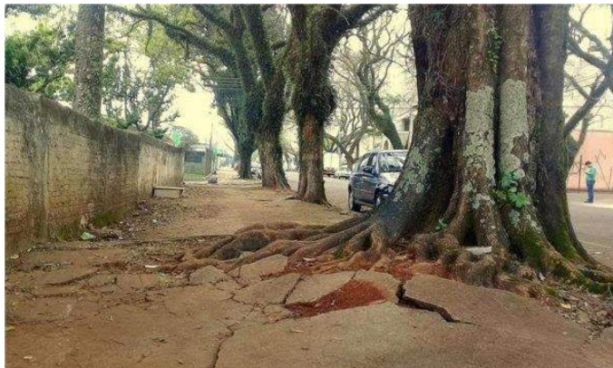
Figura 13 – Raízes destroem calçada
