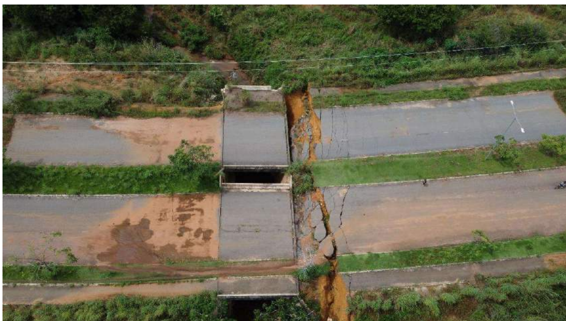
Figura 31 – Tabuleiro das pontes sobre a NS-03
