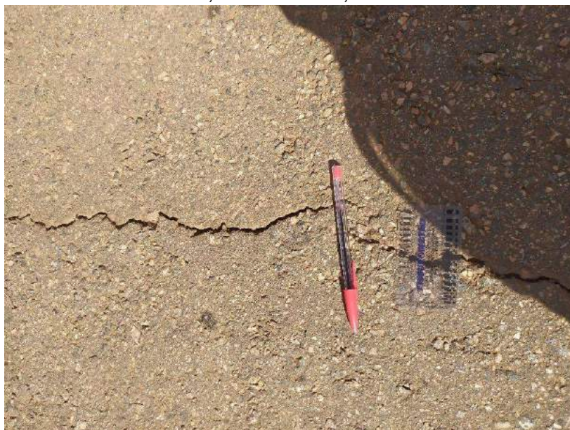
Figura 66 – Ensaio de esclerometria na pista de rolamento, cabeceira sul, sentido norte-sul, abertura de 2,3 mm
