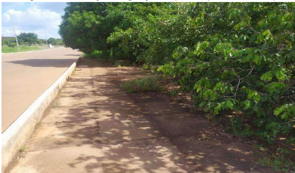
Figura 45 – Presença de vegetação em passeio (sentido norte-sul)
