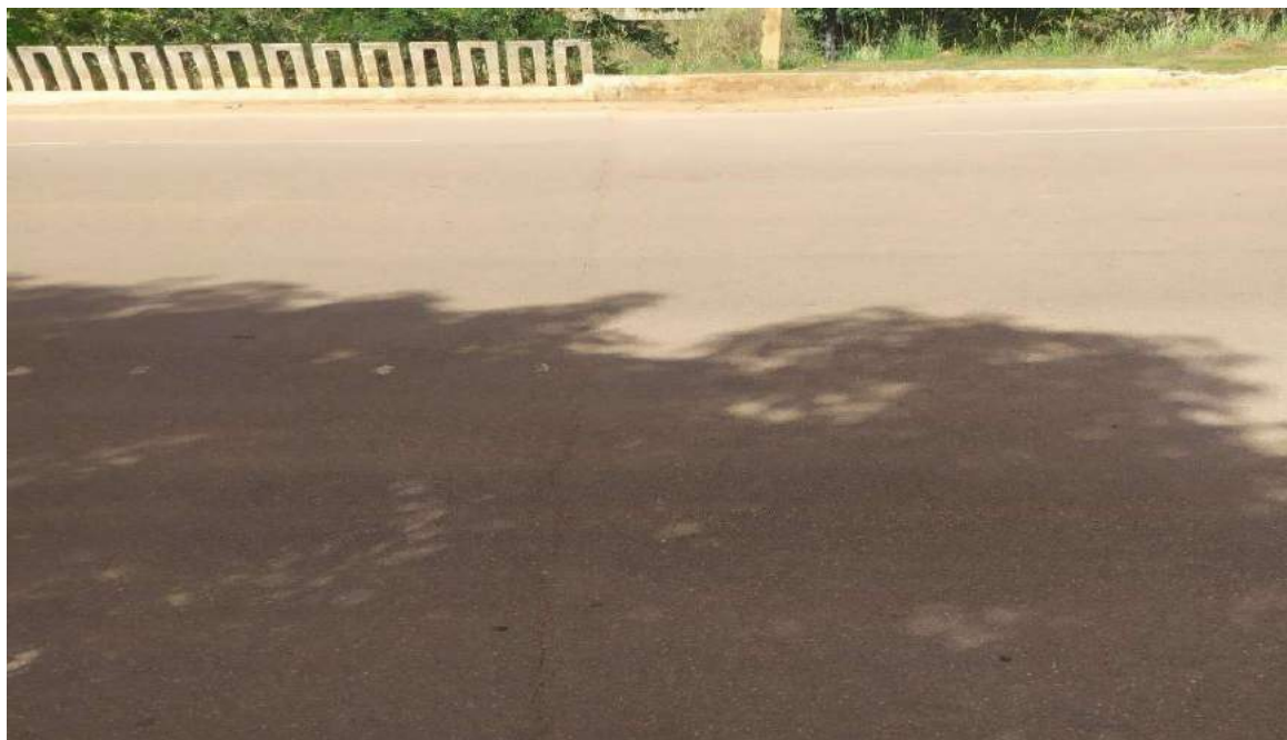
Figura 49 – Pequeno degrau no tabuleiro (sentido norte-sul)
