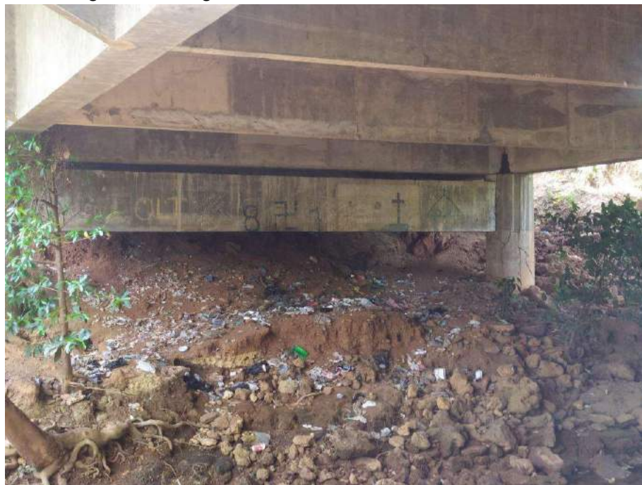
Figura 56 – Viga de travamento norte, sentido norte-sul
