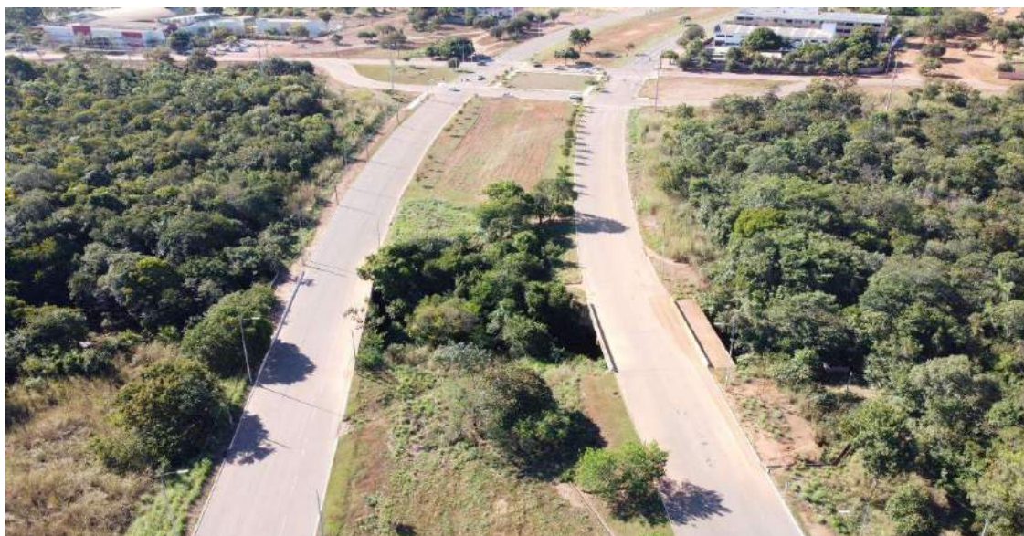
Figura 44 – Pontes da Avenida Teotônio Segurado, sobre o córrego Sussuapara em 2021
