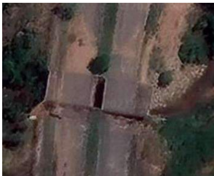
Figura 28 – Pontes da Avenida NS-03, sobre o córrego Sussuapara, sentidos sul-norte e norte-sul
