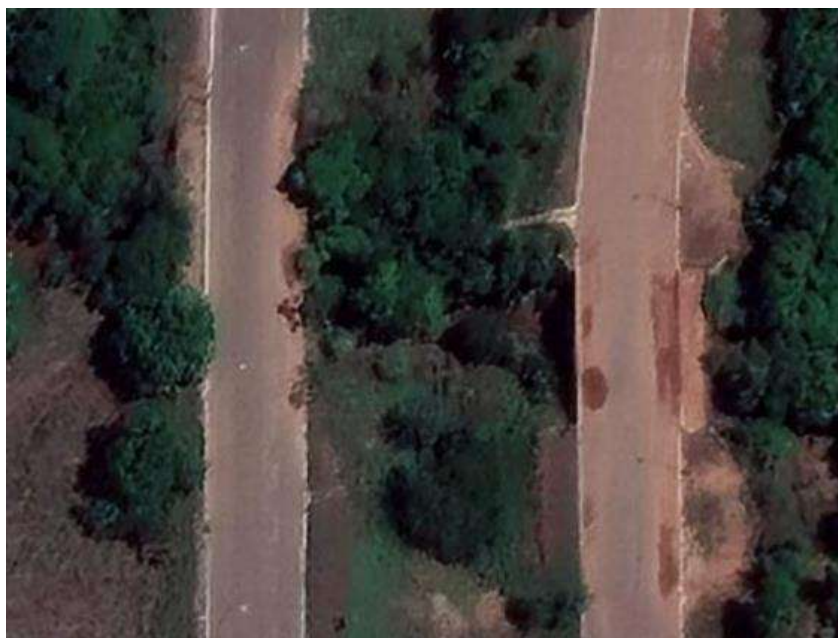
Figura 29 – Pontes da Avenida Teotônio Segurado, sobre o córrego Sussuapara, sentidos norte-sul e sul-norte
