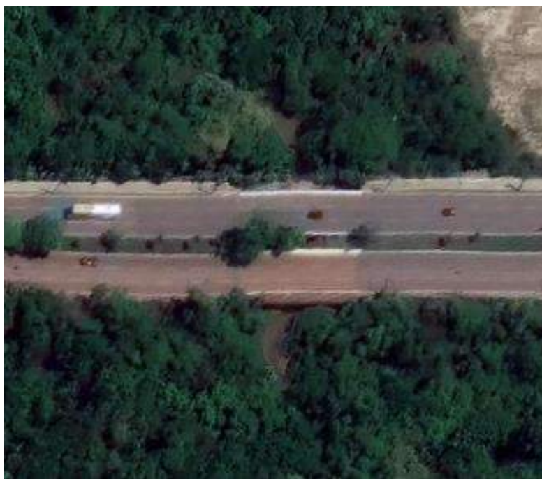
Figura 27 – Pontes da Avenida JK, sobre o córrego Brejo Comprido, próxima ao Capim Dourado Shopping, sentidos oeste-leste e leste-oeste
