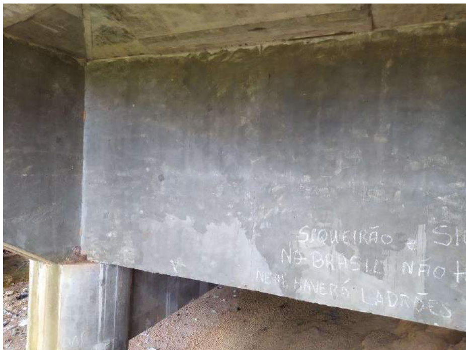
Figura 57 – Longarina oeste, sentido norte-sul
