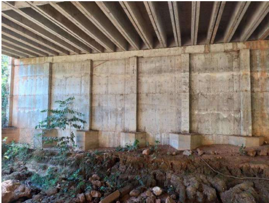
Figura 55 – Parede de contenção norte, sentido sul-norte
