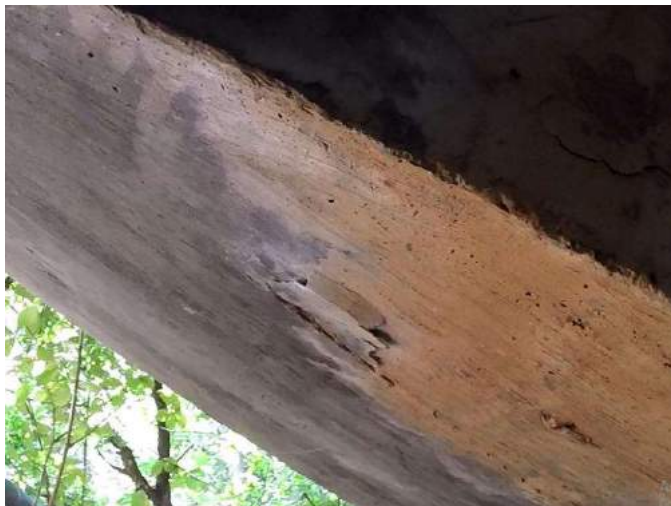
Figura 79 – Vergalhão exposto na longarina, sentido leste-oeste
