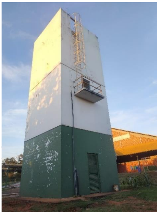
Figura 20 – Reservatório elevado em concreto armado
