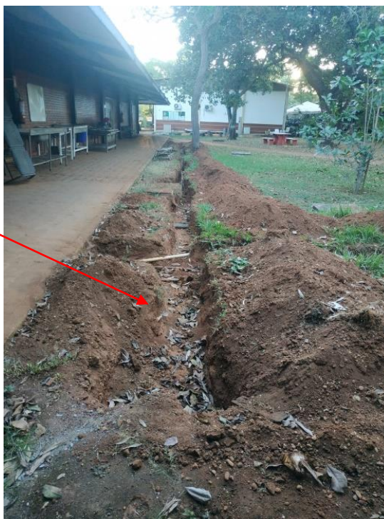
Figura 38 – Tubulação de água do bloco 10
