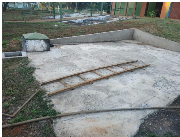
Figura 21 – Vista superior do reservatório enterrado
