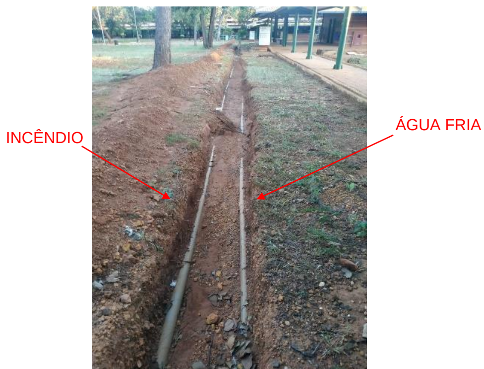
Figura 30 – Ramal alimentador dos blocos 04, 06, 08 e 10
