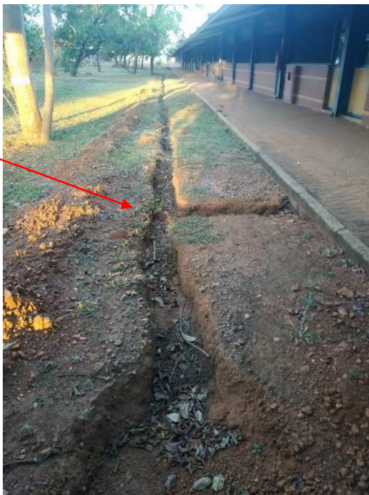
Figura 37 – Tubulação de água do bloco 09
