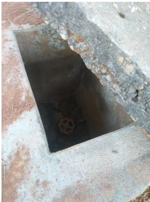
Figura 43 – Registro de água do auditório Bloco 3
