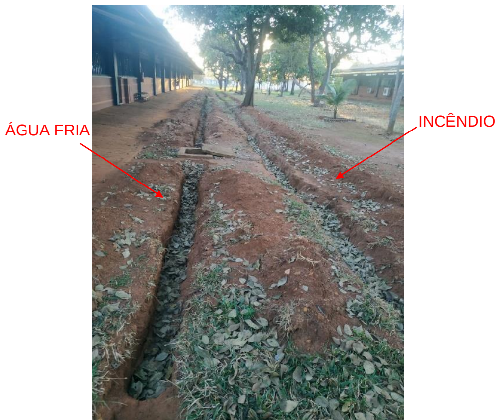
Figura 25 – Ramal de água do bloco 04
