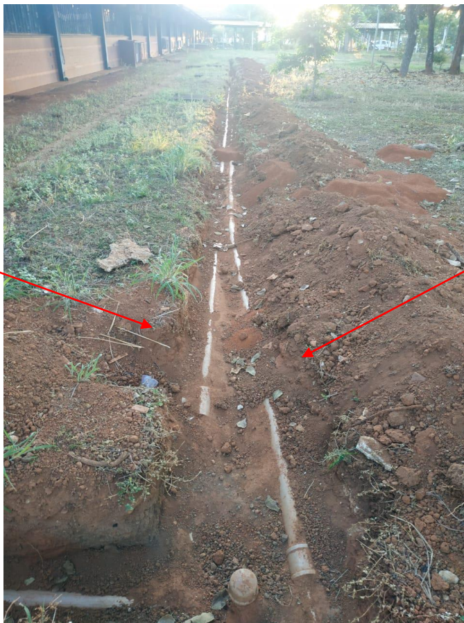
Figura 23 – Ramal de água do bloco 02
