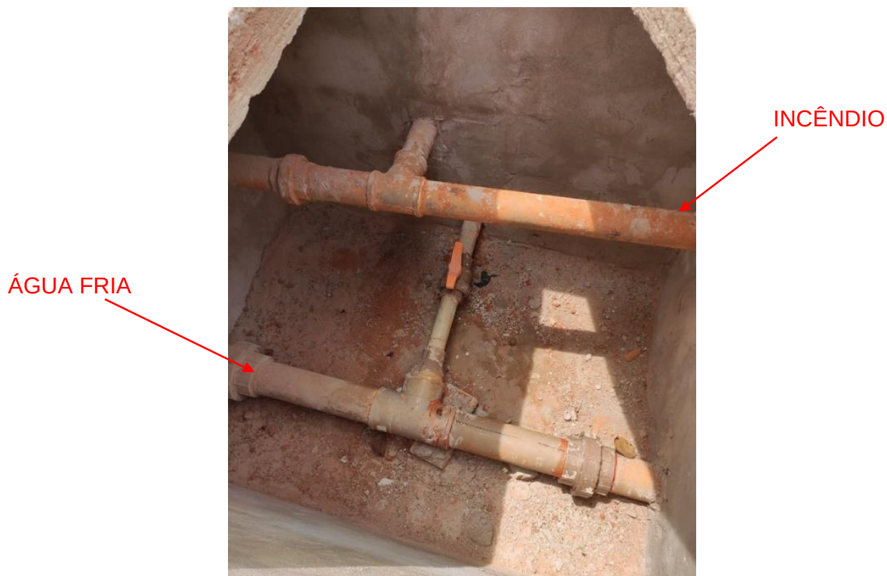
Figura 22 – Vista dos ramais que saem dos reservatórios
