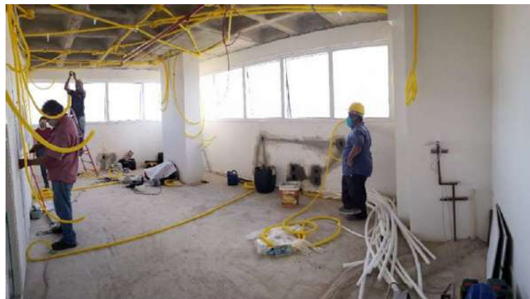
Figura 18 - Passagem de eletrodutos
