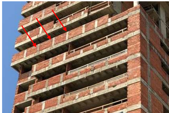
Figura 19 - Pilaretes da fachada frontal do edifício
