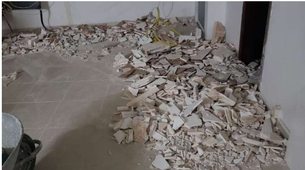
Figura 32 - Parte do entulho da demolição
