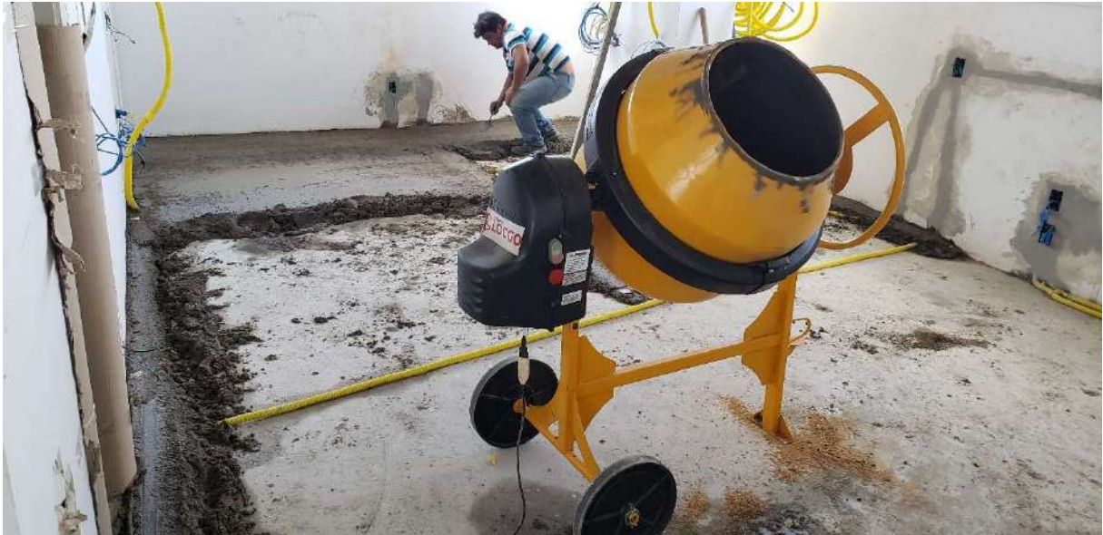
Figura 20 - Execução do contrapiso
