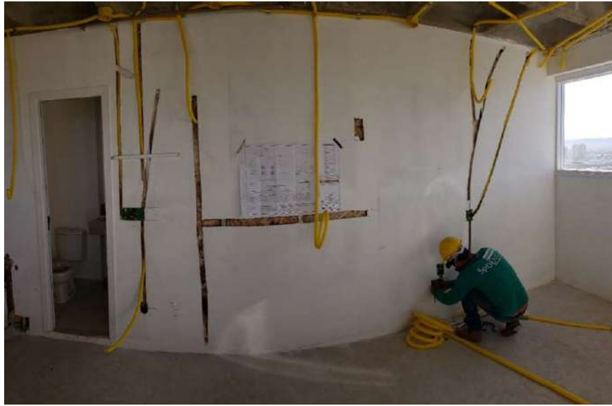
Figura 22 - Parede que recebeu as duas evaporadoras
