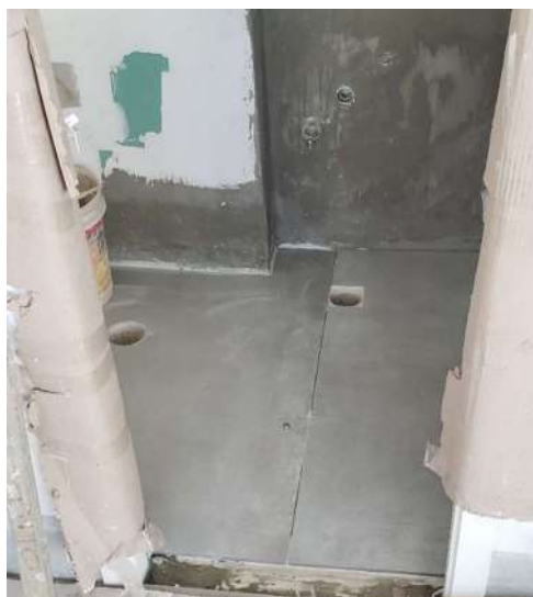
Figura 24 - Impermeabilização do lavabo
