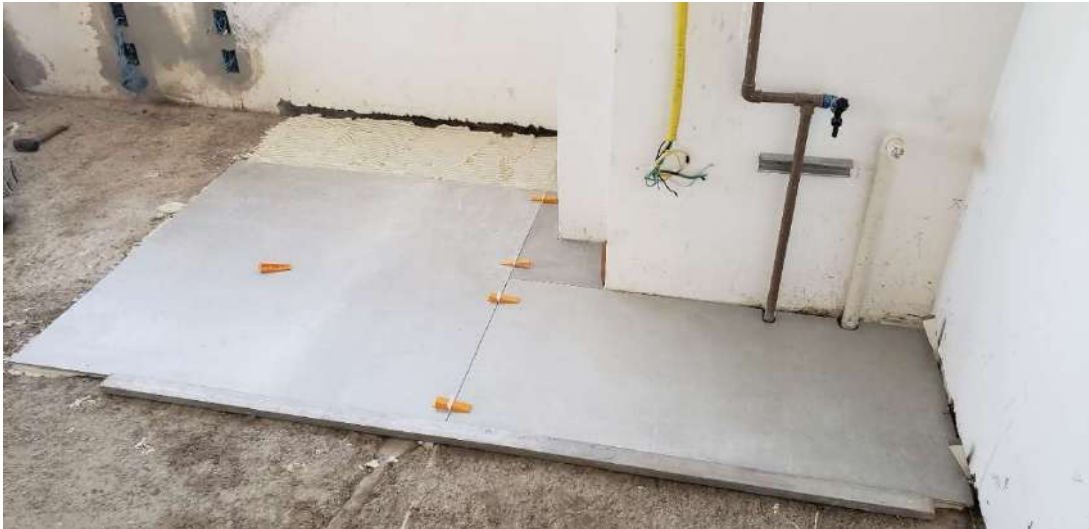
Figura 23 - Assentamento de porcelanato
