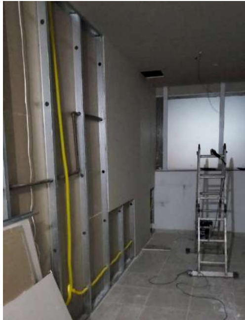
Figura 37 - Construção da parede divisória em drywall
