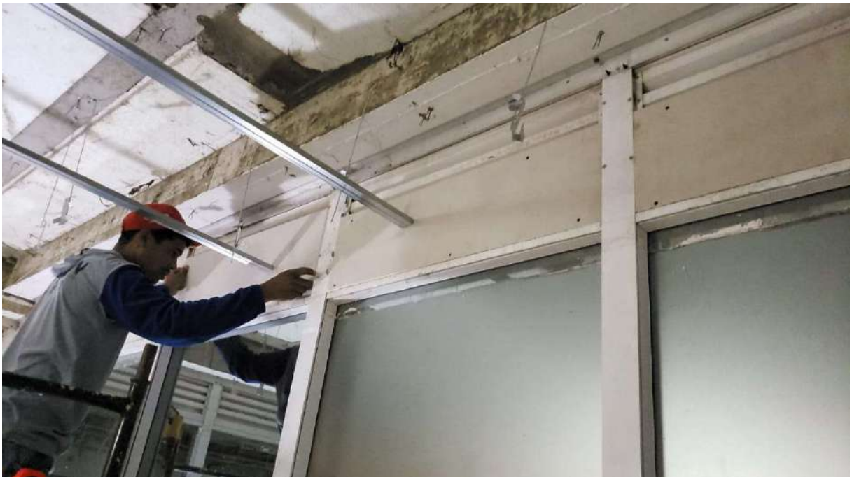
Figura 36 - Vedação das janelas venezianas sobre esquadrias de vidro
