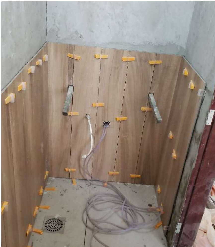
Figura 39 - Revestimento do banheiro assentado
