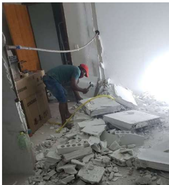
Figura 38 - Retrabalho de demolição
