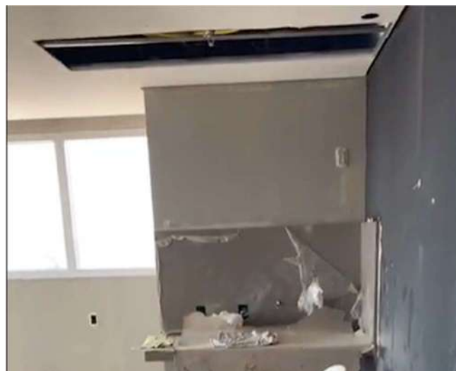
Figura 29 - Abertura no forro para instalação da porta de correr da copa
