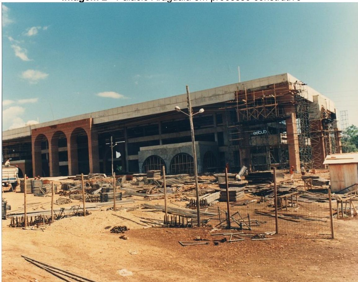
Imagem 2 - Palácio Araguaia em processo construtivo
