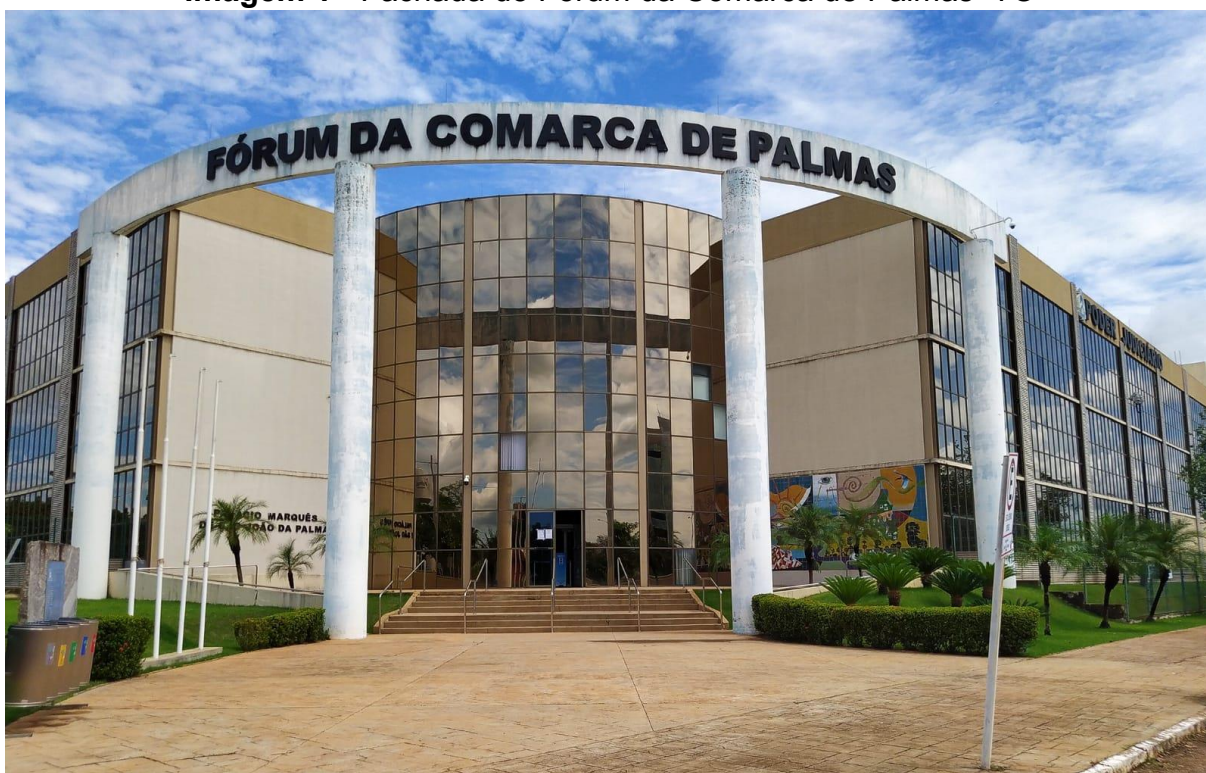
Imagem 1 - Fachada do Fórum da Comarca de Palmas–TO
