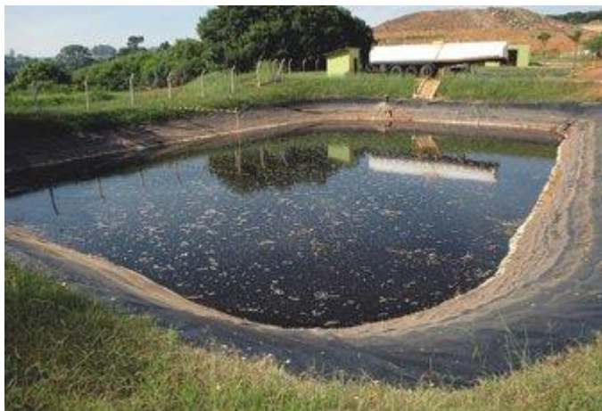
Figura 2 - Depósito de chorume de aterro sanitário
