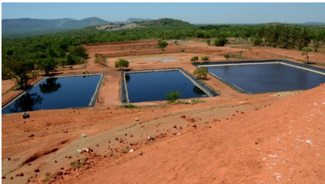
Figura 4 - Tratamento de chorume em lagoas de estabilização no Aterro Sanitário de Palmas (TO)
