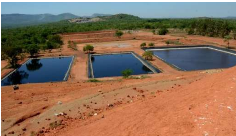
Figura 12 – Sistema de tratamento do chorume Fonte: Autor
