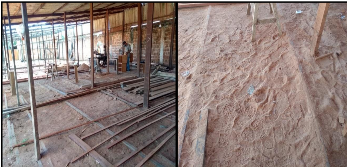
Figura 14 - Disposição do pó de serra (pó fino)
