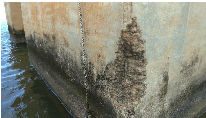
Figura 46- Desgaste na P14
