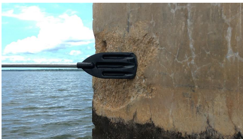
Figura 50 - Abrasão ocorrido na P12
