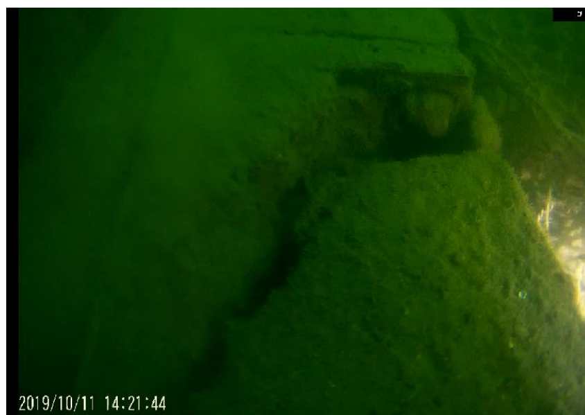
Figura 76 – Rachadura – P21
