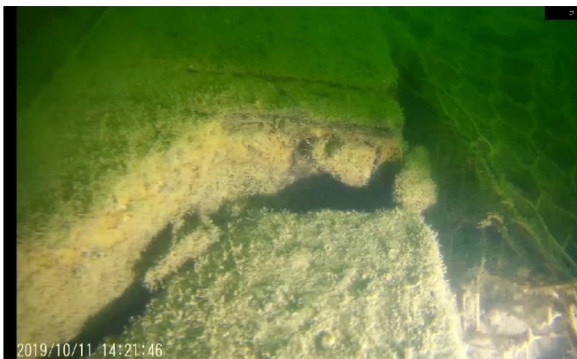
Figura 75 – Rachadura na base do bloco – P21
