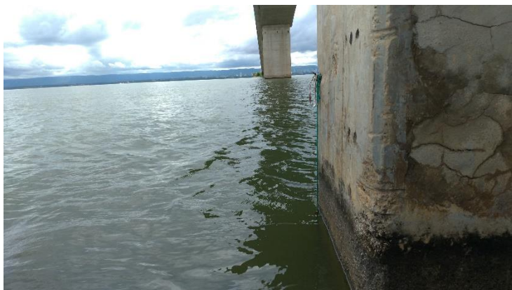
Figura 54 – Ponto de ancoragem de embarcação - P11
