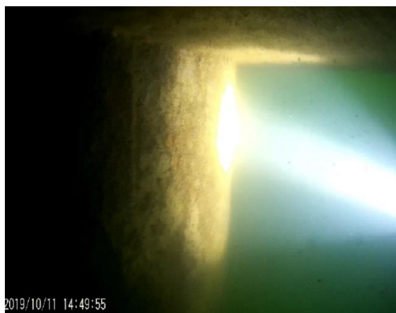
Figura 80 -Tubulão – 16 metros de profundidade P- 20
