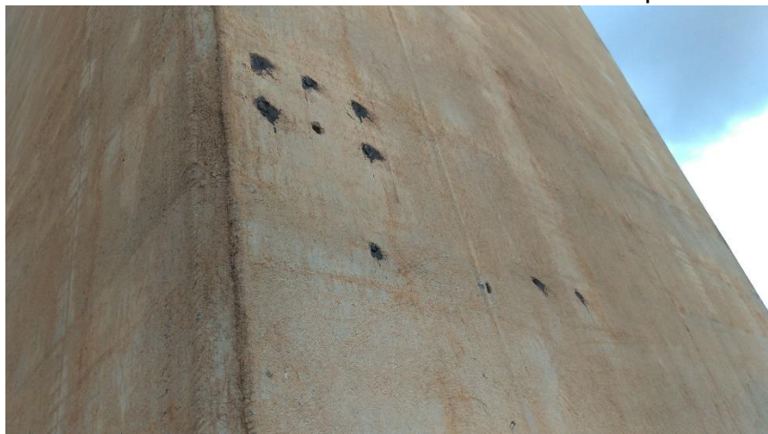
Figura 69 - Barras tratadas com material derivado de petróleo - P13
