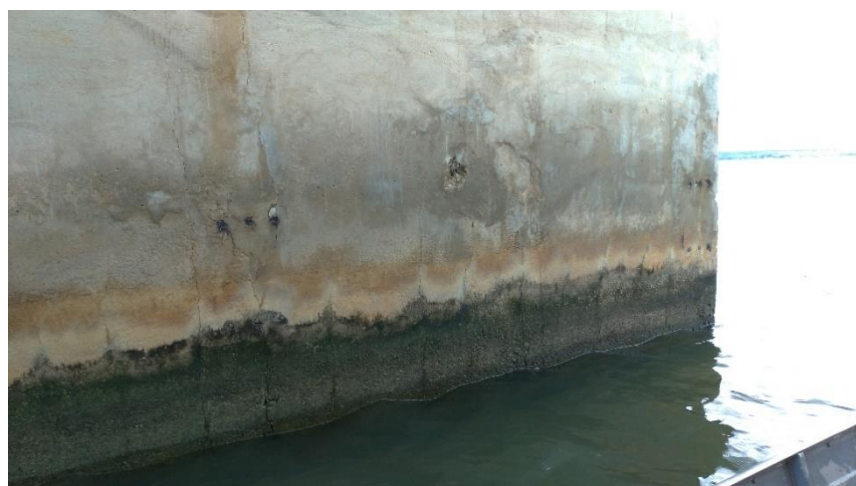
Figura 70 – Pontos de fixação formas - P11
