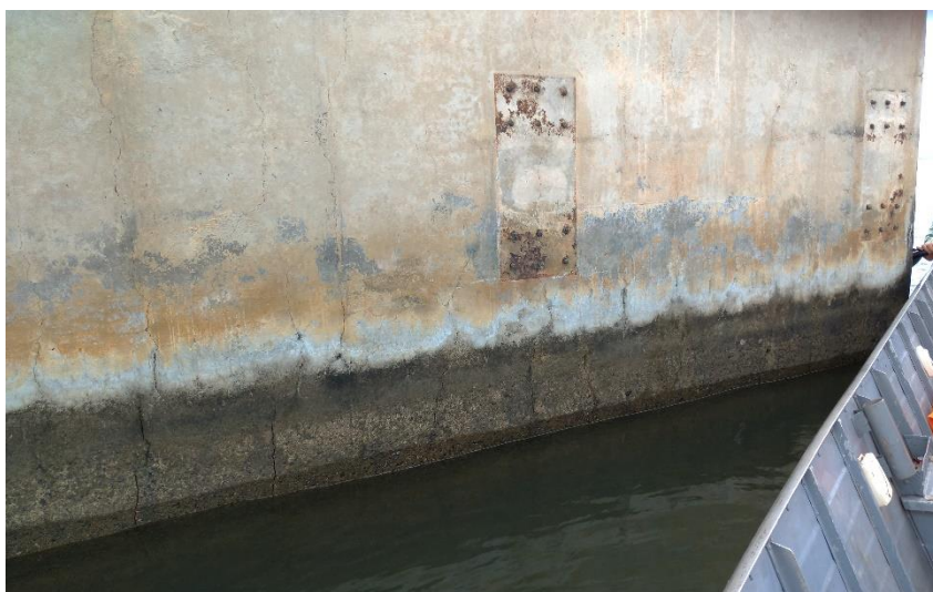
Figura 71 – Ponto de fixação das formas – P12
