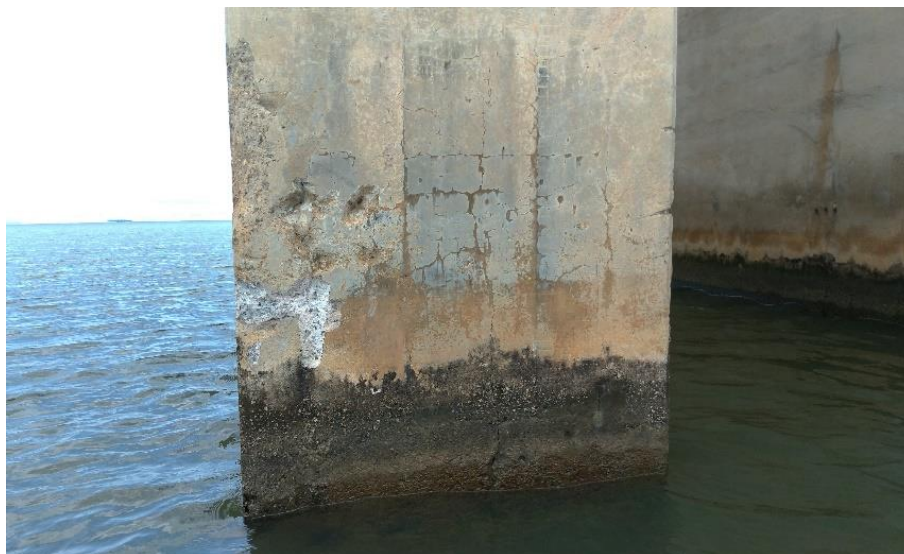
Figura 51 - Múltiplos pontos de abrasão – P11
