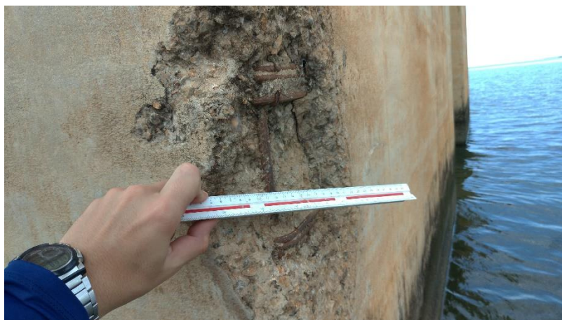
Figura 47- Comprimento da abrasão - P14
