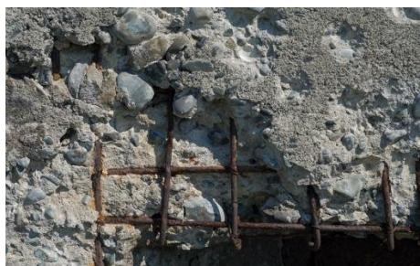
Figura 26 - Exemplo de Desagregação
