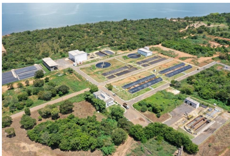
Figura 1 - Estação de Tratamento de Esgoto - ETE Norte
