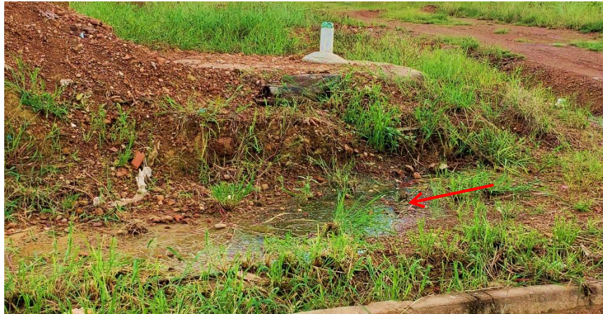
Figura 28 – Extravasamento de fossa com formação de limo (Rua Tocantins)
