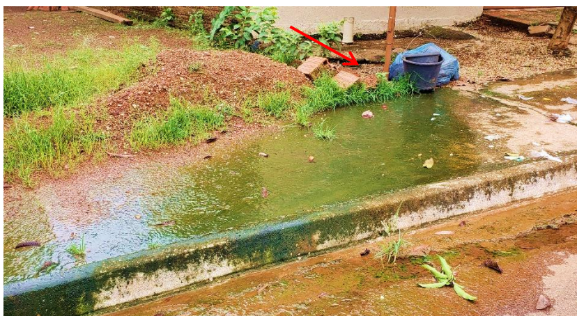
Figura 26 – Extravasamento de fossa com formação de limo (Rua 5 de Abril)
