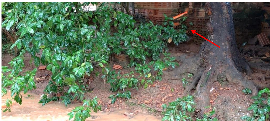
Figura 56 – Descarte incorreto de esgoto doméstico diretamente na grota da Leozina mediante prolongamento de cano (Rua Maranhão)
