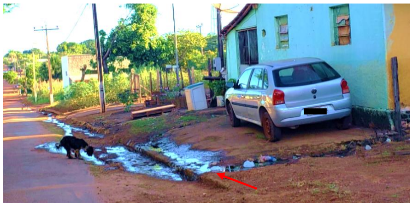
Figura 53 – Descarte incorreto de esgoto doméstico e animais utilizando esse efluente para consumo na (Avenida dos Estudantes)
