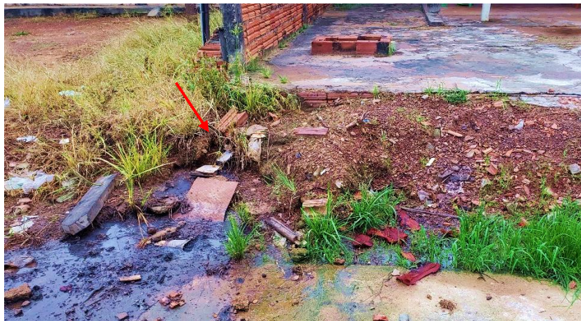
Figura 48 – Extravasamento de fossa, descarte incorreto de esgoto doméstico e acúmulo de lixo (Rua 5 de Abril)
