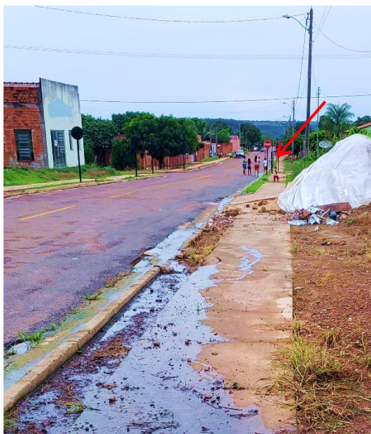
Figura 34 – Caminho preferencial dos extravasamentos das fossas na Rua 5 de Abril (Setor Bela Vista) para pontos comerciais no Setor Aeroporto
