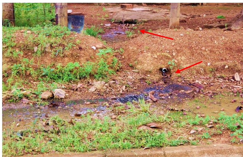
Figura 49 – Extravasamento de fossa e descarte incorreto de esgoto doméstico com formação de limo (Rua Tocantins)
