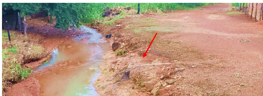
Figura 55 – Descarte incorreto de esgoto doméstico diretamente na grotta da Leozina mediante prolongamento de cano (Rua Maranhão)
