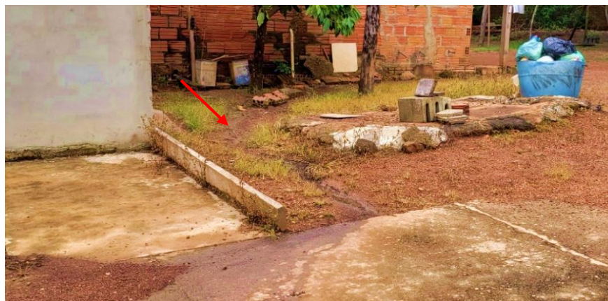
Figura 52 – Descarte incorreto de esgoto doméstico (Rua 5 de Abril)
