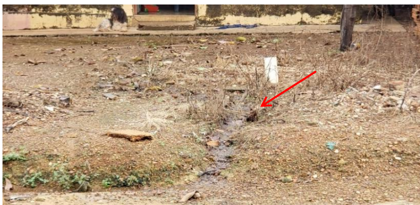
Figura 27 – Extravasamento de fossa (Rua 5 de Abril)
