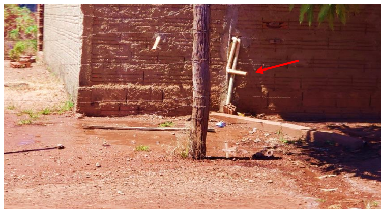
Figura 54 – Descarte incorreto de esgoto doméstico (Avenida Maria José)
