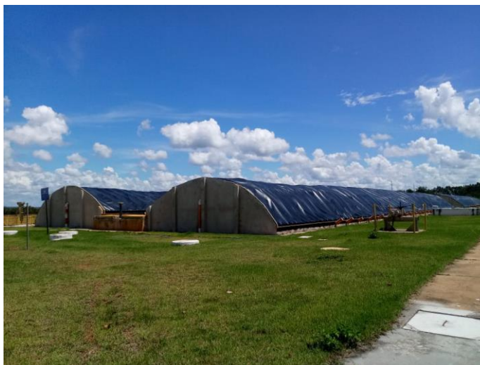
Figura 5 - Reator Anaeróbio de Fluxo Ascendente.
