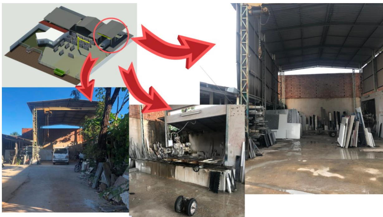
Figura 18 – Situação atual da doca de recebimento das placas/ máquina de corte
