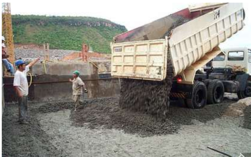
Figura 7 - Transporte realizado por caminhão basculante
