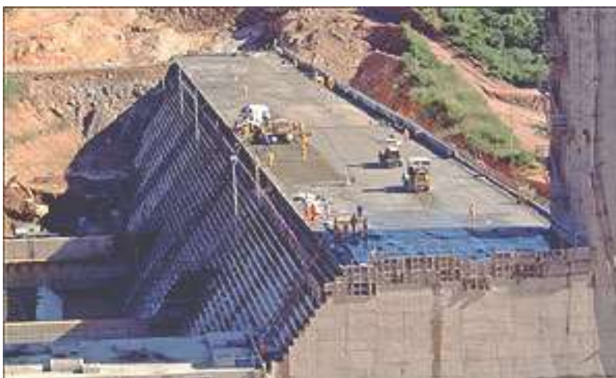
Figura 8 - Lançamento do CCR pelo método tradicional
