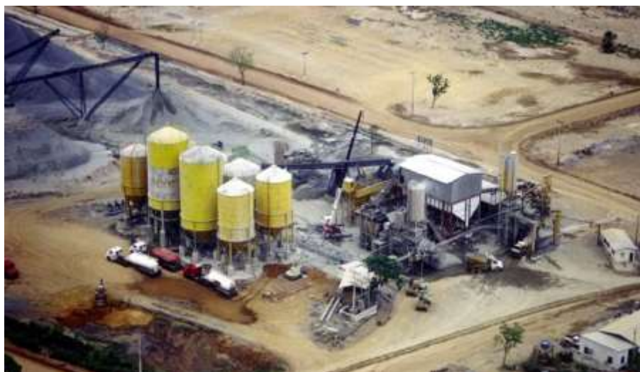
Figura 6 - Central de concreto da UHE Lajeado
