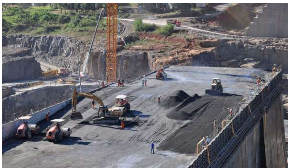
Figura 9 - Lançamento do CCR pelo método rampado
