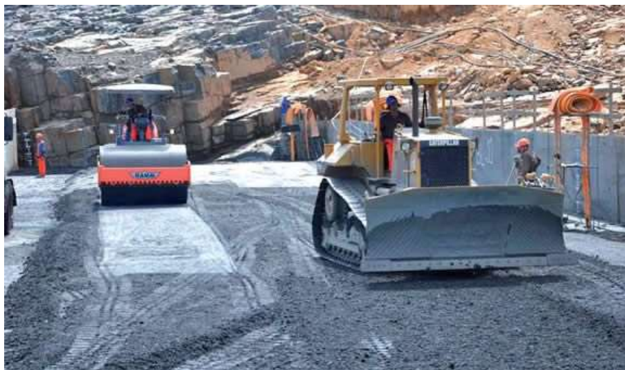
Figura 10 - Compactação do CCR
