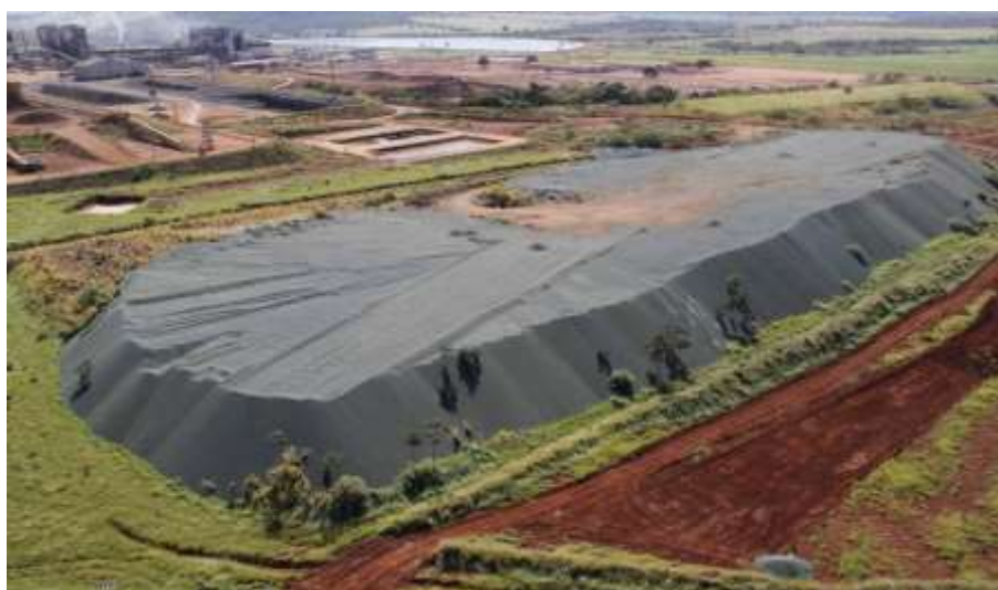
Figura 21 - Depósito de escória de ferroníquel em Barro Alto - GO
