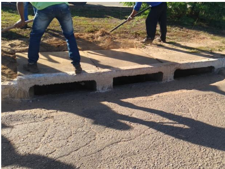
Figura 46 - Boca de lobo de guia limpa
