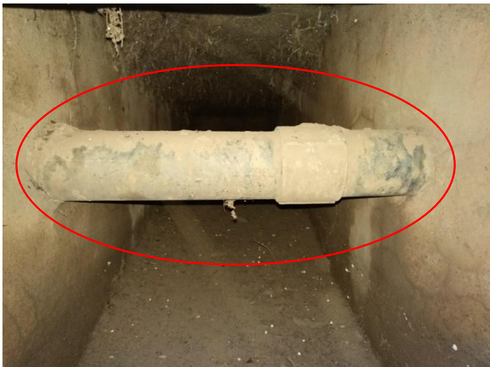
Figura 48 - Intercepção do ramal coletor
