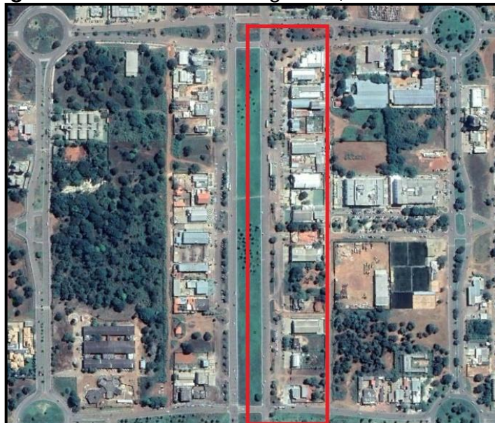
Figura 20 - Av. Teotônio Segurado, trecho de estudo
