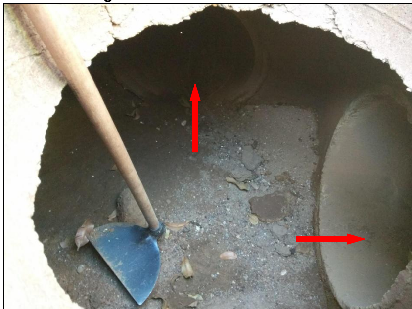
Figura 50 - Vista interna do PV 01
