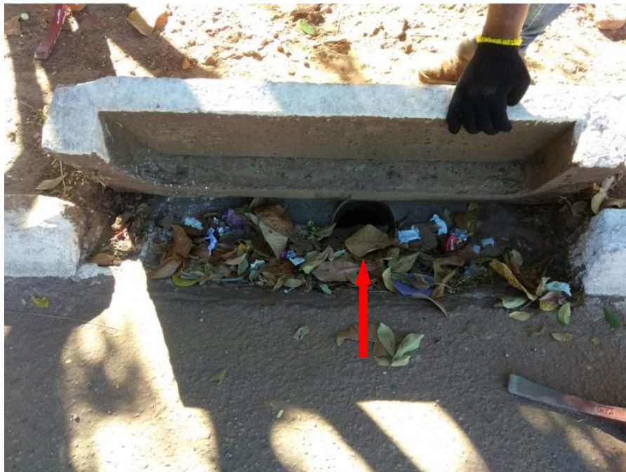
Figura 51 - Caixa de drenagem simples
