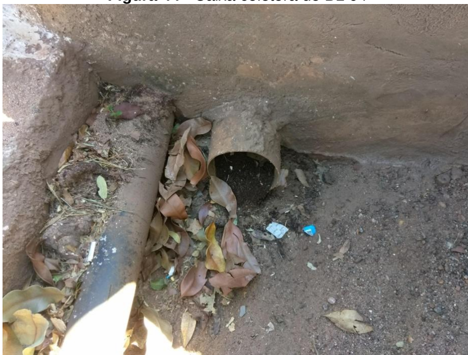
Figura 44 - Caixa coletora do BL 04
